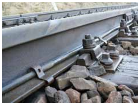
Jedna z možností náhrady nadzemného vedenia je kábel upevnený k päte koľajnice.
