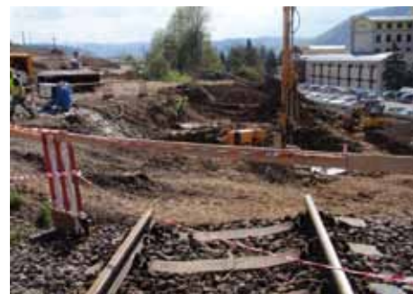
Na tomto mieste ešte v lete nebolo takmer nič. Dnes je doprava opäť v prevádzke aj spolu s dvomi novými železničnými mostami.
