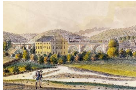
Vlak Uhorskej centrálnej železnice na Červenom moste pri Bratislave v polovici 19. storočia.
