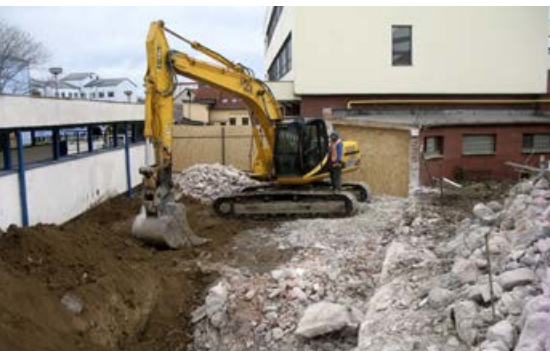
Takto vyzeralo búranie bývalého batožinového podchodu v decembri, podchod pre cestujúcich vľavo na zbúranie čaká.
