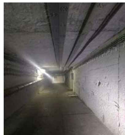
Takto vyzerá existujúci podchod, ktorý po rekonštrukcii umožní napríklad cestujúcim s ťažkou batožinou jednoduchší prechod na nástupištia.
