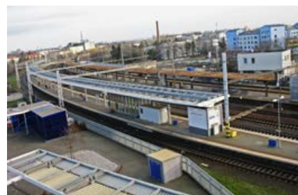
Nástupište č. 2 čaká v roku 2018 tiež rekonštrukcia.
