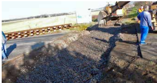
...aby sa mohli pustiť do vybagrovania štrkového lôžka pod pôvodnou konštrukciou priecestia.
