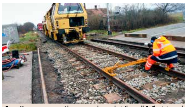
Po opätovnom zasypaní kamennou drvou zhutnila podbijačka toto podložie koľaje.
