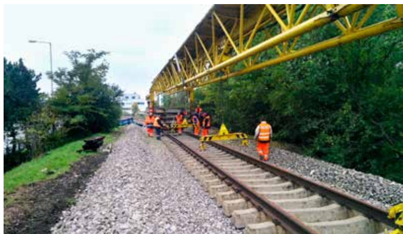
Súčasťou výluk bola aj pokládka trate.
