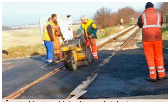
Čerstvý asfaltový povrch bolo takisto potrebné zhutniť a, samozrejme, aj vyrovať.
