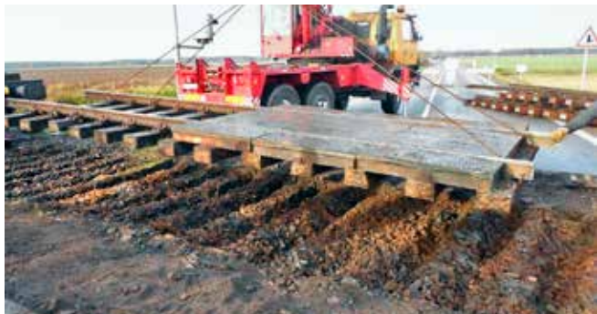
Najprv bolo potrebné vybrať pôvodnú konštrukciu priecestia pomocou žeriavu...
