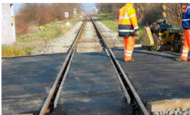
Okrem priestoru medzi koľajami pracovníci asfaltovým povrchom plynule naviazali na existujúcu komunikáciu.
