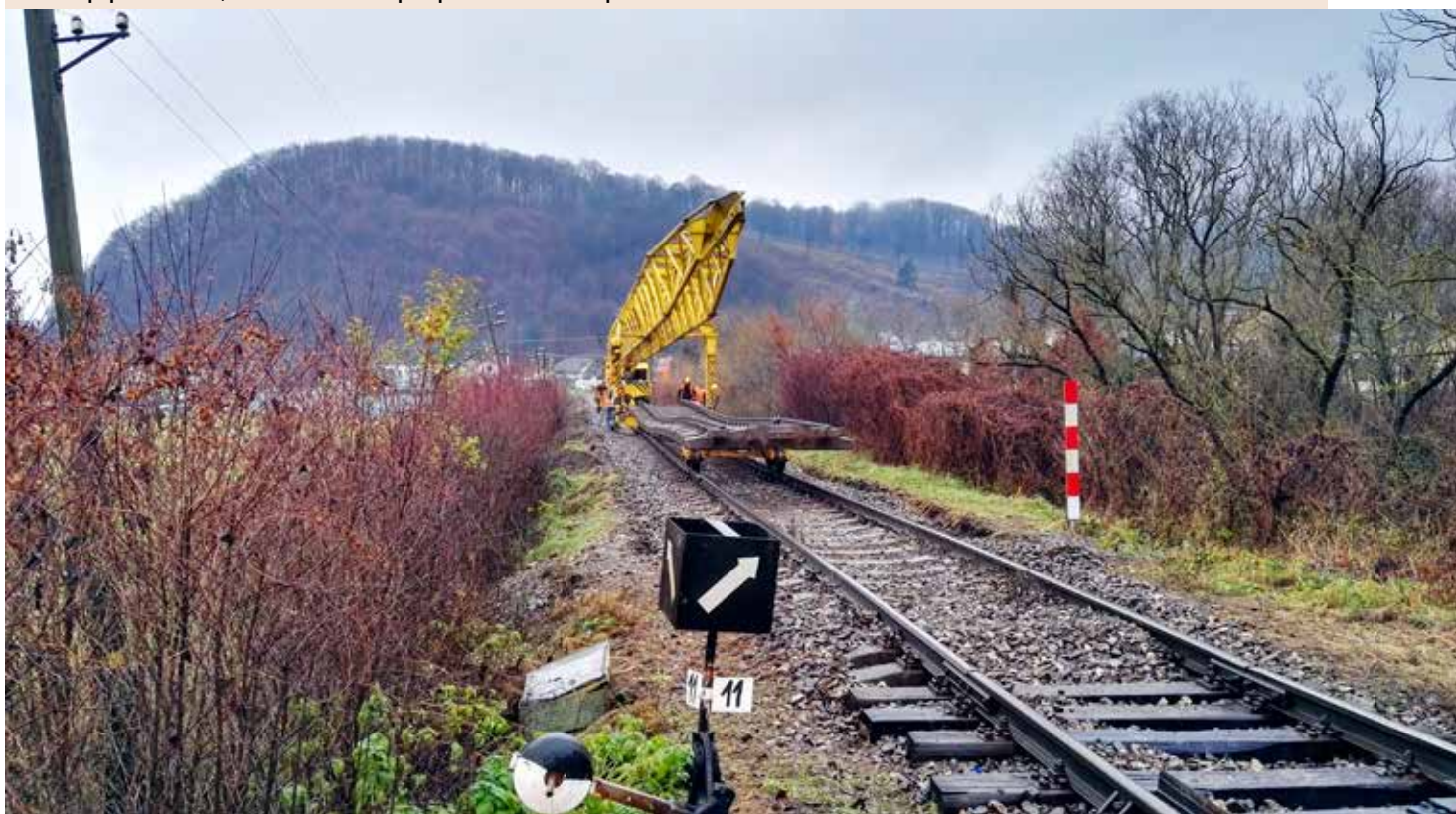
Stroj PKP 25 - Tatra s dlhým ramenom pomohol s uložením koľajového poľa na svoje miesto.
