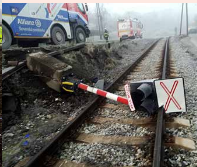
Šmyk kamiónu a jeho následné vojenie do koľaje spôsobilo poškodenie výstražníka aj podvalu.
