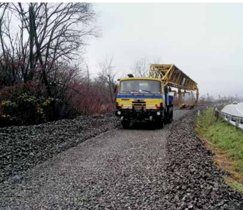
Stroj PKP 25 - Tatra s dlhým ramenom pomohol s uložením koľajového poľa na svoje miesto.
