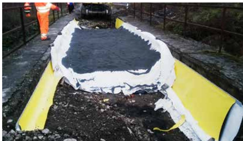
Realizácia novej hydroizolácie na moste ponad jeden z malých prítokov rieky Cirocha.
