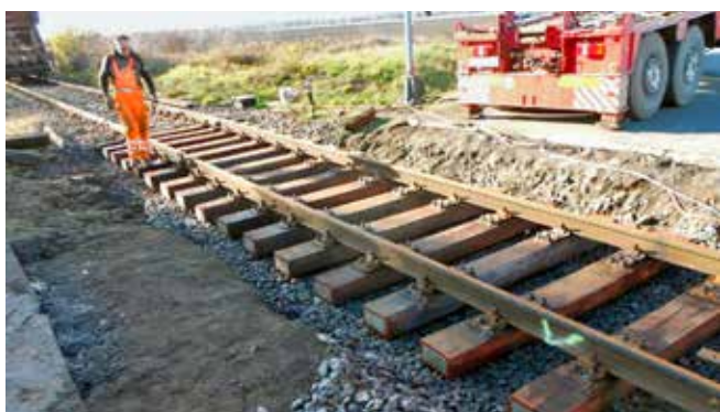
Na čisté štrkové podložie uložili vynovené koľajové pole.
