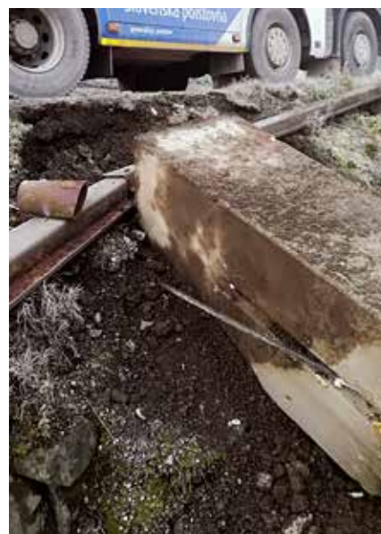
Šmyk kamiónu a jeho následné vojenie do koľaje spôsobilo poškodenie výstražníka aj podvalu.
