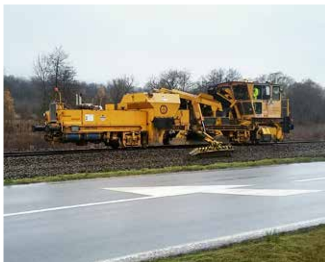
Za pomoci ďalšieho stroja bol upravený železničný štrk po stranách koľaje.
