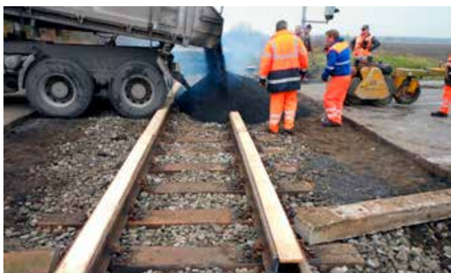
Koľajové pole pripravili na asfaltovanie a následne ho zasypali asfaltom.
