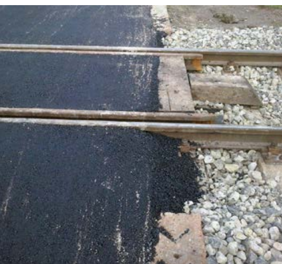
Vyasfaltované nábehy komunikácie a vyplnené železničné priecestie, všetky práce zrealizovali zamestnanci ŽSR.
