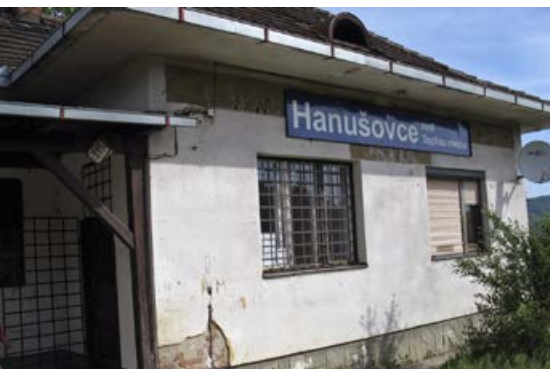
Železničná zastávka Hanušovce nad Topľou pred rekonštrukciou...
