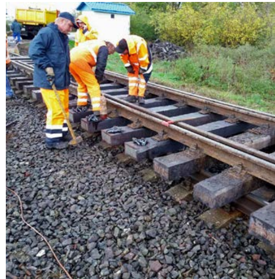
...na vybratom koľajovom poli z priecestia sa robotníci postarali o výmenu starých drevených podvalov za nové.
