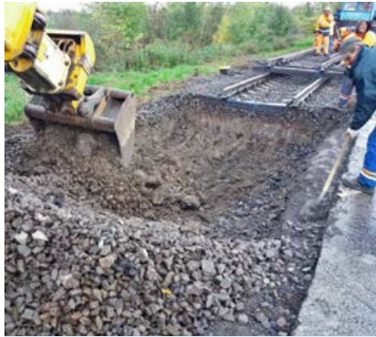
Práce začali vytrhnutím 15 metrového koľajového poľa na drevených podvaloch v žkm 26,480 – 26,495 s následnou úpravou koľajového lôžka...
