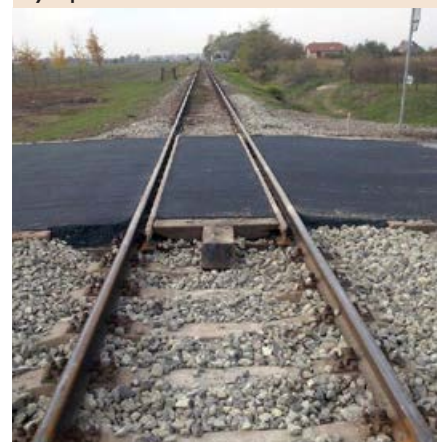
Pohľad na priecestie po skončení rekonštrukčných prác.
