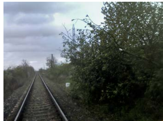
Aj v úseku Rišňovce – Hlohovec ohlásil rušňovodič strom spadnutý na trať, spôsobilo to meškanie 3 vlakov.
