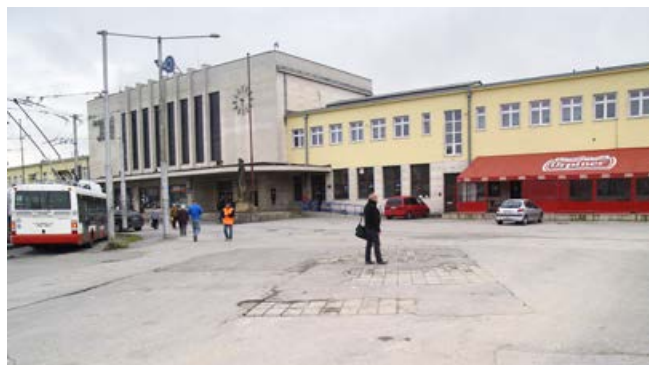
Predstaničný priestor pred výstavbou.
