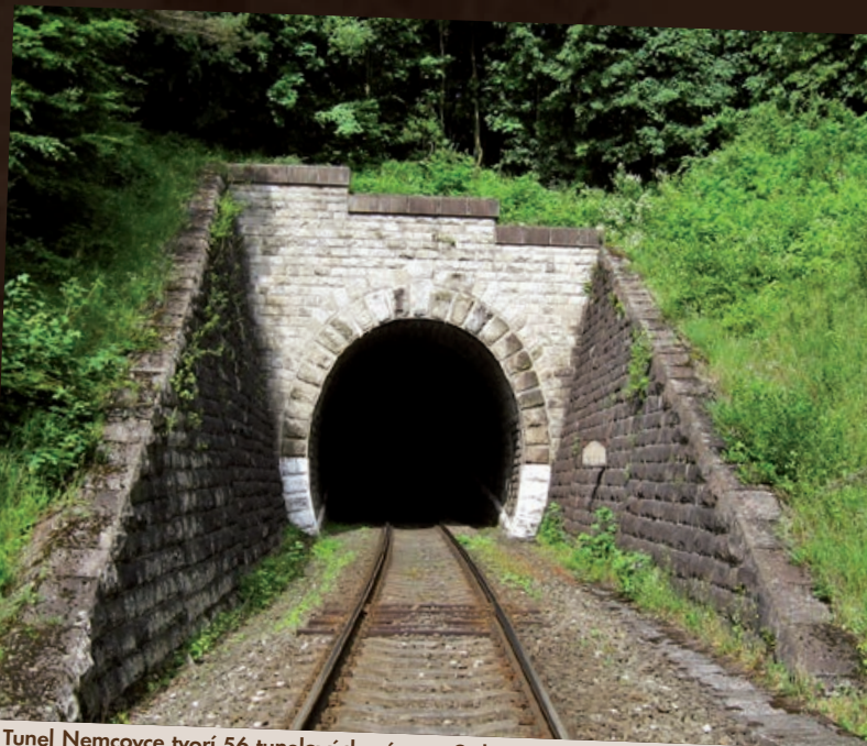
Tunel Nemcovce tvorí 56 tunelových pásov s 9 dvojicami bezpečnostných výklenkov.
