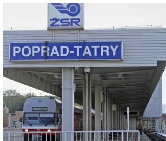
Pri rekonštrukcii nástupíšť TEŽ sa obnovila povrchová vrstva nástupíšť, očistila a obnovila sa strešná krytina, pribudli nové nátery oceľovej konštrukcie.
