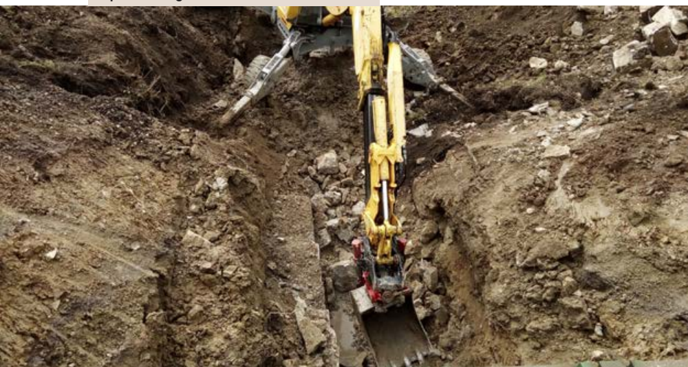
Práce na opravách priepustu sa vykonávajú pod ochranou 18,5-metrového mostného provizória
