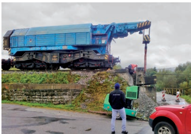
Po demontáži spodnej stavby mosta v Tvrdošíne...
