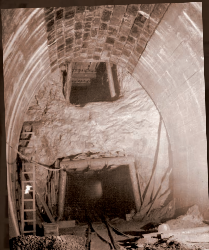
Historická fotografia z výstavby tunela. S razením spodnej smerovej štôľne sa začalo v roku 1939. Zdroj: archív MDC
