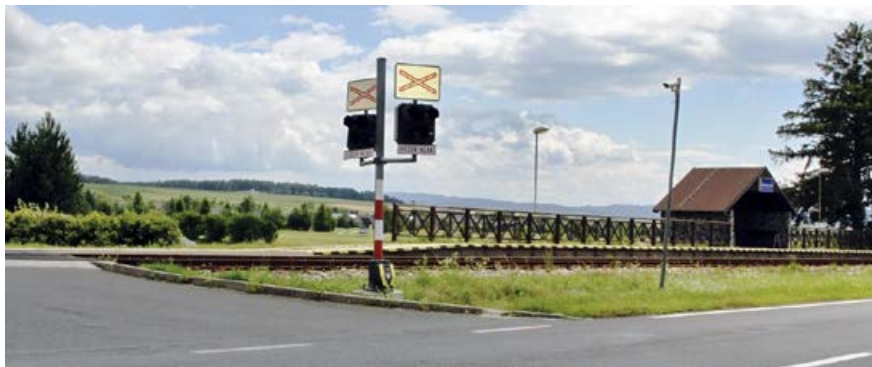
Ostro sledované železničné priecestie je v blízkosti železničnej zastávky Veľká Lomnica – Golf.
