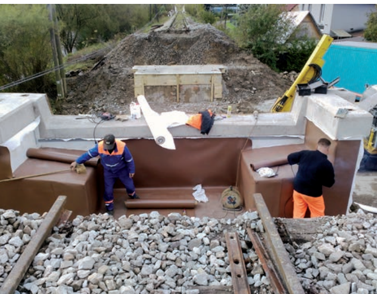
...nasledovala oprava spodnej stavby mosta a montáž úložných prahov...
