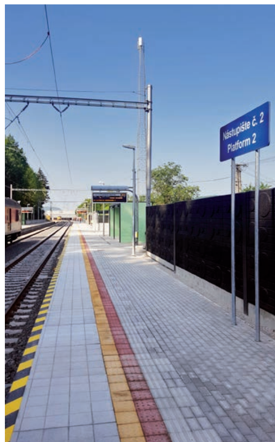
Už len záverečné úpravy v podobe montáže obrubníkov a dlažby na nástupišti pri 2. traťovej koľaji zostáva zrealizovať na zastávke Horný Hričov.
