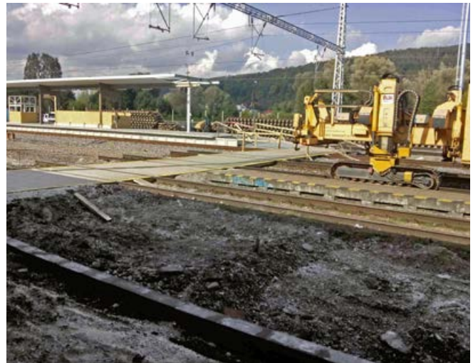
Železničná stanica v Považskej Bystrici je aktuálne veľkým staveniskom.
