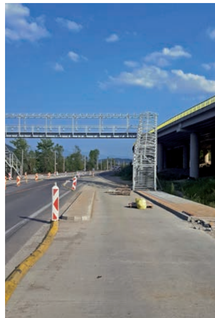
Nová lávka pre peších medzi Dolným Hričovom a Žilinou si ešte vyžiada montáž zastrešenia a dobudovanie zábradlia.
