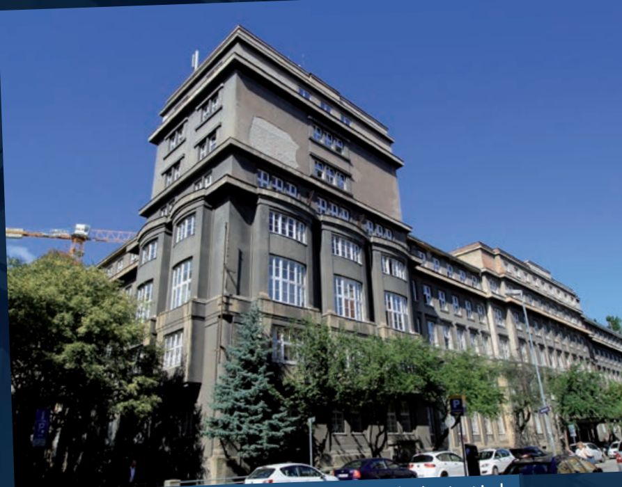
Budova sa nachádza na Klemensovej ulici, na ktorej je viac budov, ktoré patria do zoznamu národných kultúrnych pamiatok.
