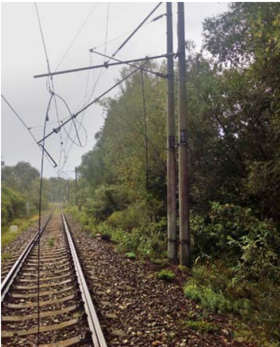
V úseku Šaštín-Stráže – Kúty boli vplyvom nepriaznivého počasia poškodené aj ramená na trakčnej podpere 89.
