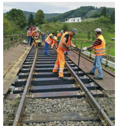
Montáž koľajnic, ktorú realizovali traťováci zo Zvolena.
