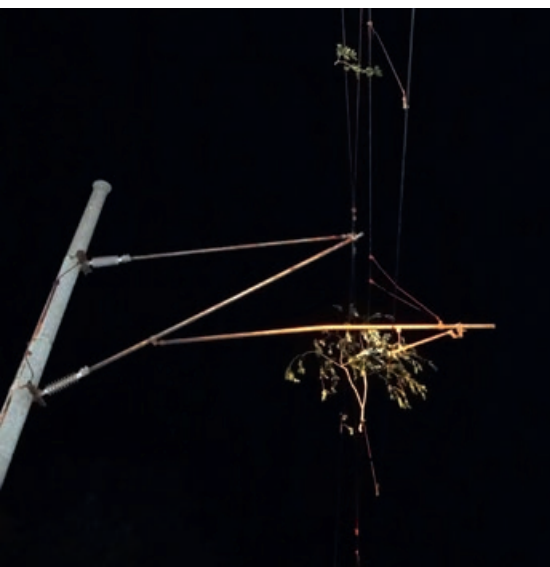
V úseku Šaštín-Stráže – Kúty boli vplyvom nepriaznivého počasia poškodené aj ramená na trakčnej podpere 89.
