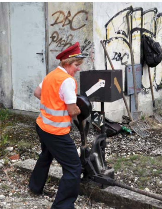
Výpravkyňa Helena Valachová zo ŽST Kostiviarska pri prestavovaní výhybky. Musela odomknúť výkoľajku a prestaviť výhybku, aby bolo možné v stanici podbiť koľaj.
