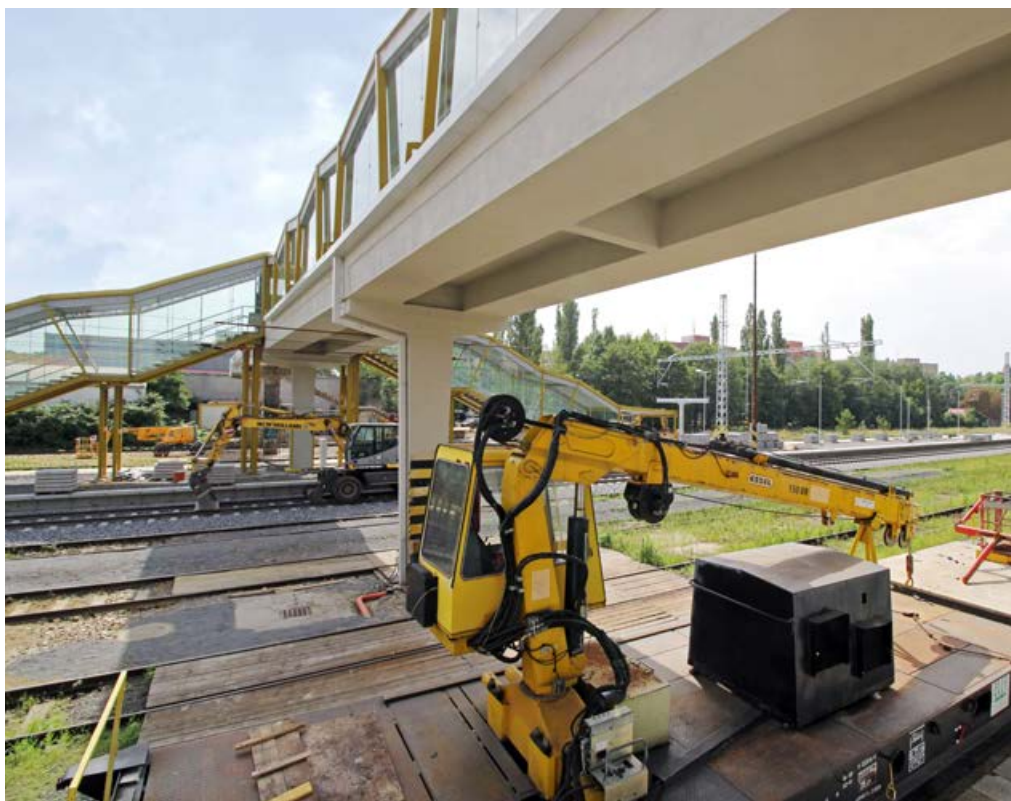
Stavebný ruch na stanici a rekonštrukčné práce aj v týchto dňoch v plnom prúde.
