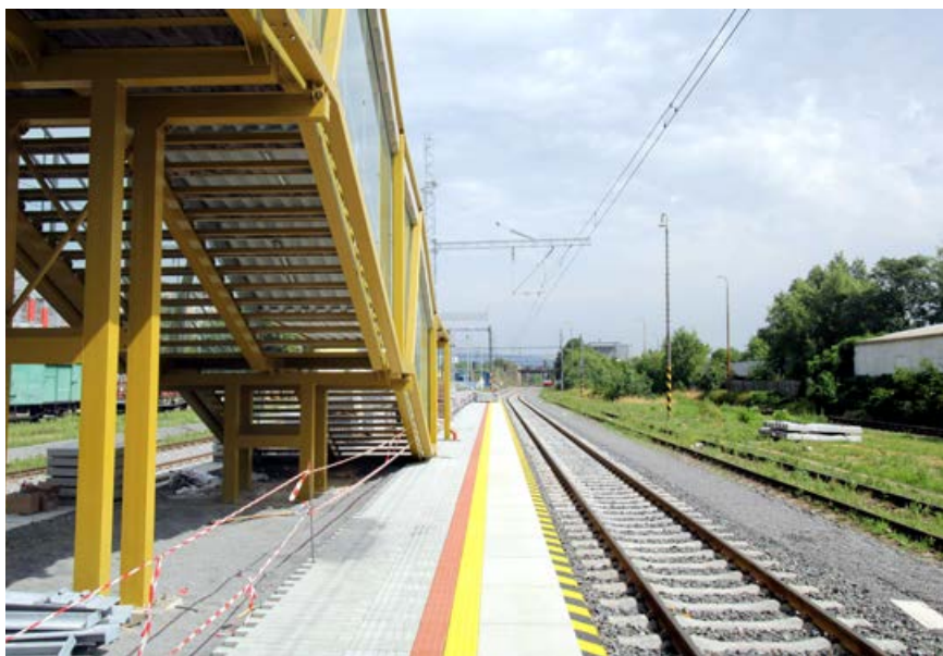
Súčasnou rekonštrukčných prác na stanici je aj oprava nástupištia.
