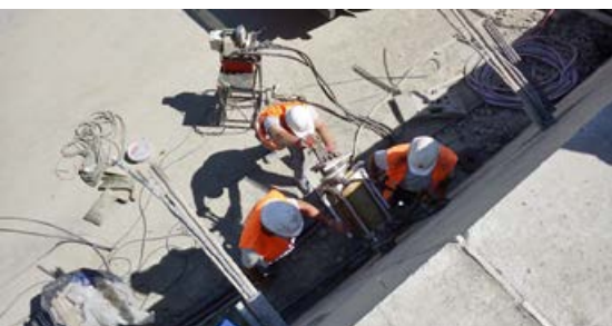
Tunel Milochovo sa ešte len začína rýsovať, ako vyplýva z fotodokumentácie, na východnom portáli už je hotový odkop zemin, injektáž a napínanie kotiev.
