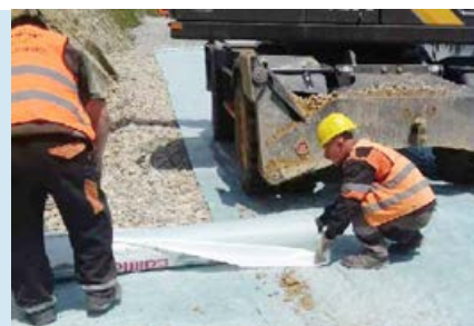
„Na západnom portáli zamestnanci Združenia Nimnica realizujú predpínanie lanových kotiev, betónujú vyústenia pre odvodňovacie vrty a dávajú ochranný náter betónu,“ približuje odborný opis aktuálneho diania J. Oláh.
