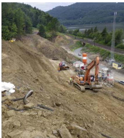
Na západnom portáli sa realizujú geodetické práce, svahovanie terénu a osadenie žľabov.
