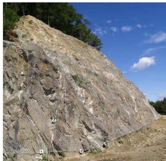
Skala je zasieťovaná a zabezpečená pred padaním skál.
