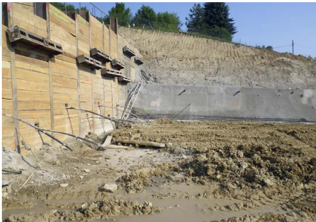
„Výrazné zmeny je možné vidieť aj na stavbe železničného spodku ŽST Považská Bystrica. Konsolidačná vrstva, odkop železničného spodku koľají č. 6, 8, ako aj betonáž základových pasov a osadenie nástupištných hrán,“ dopĺňa na záver nášho monitoringu prvej etapy odborný výklad J. Oláh.
