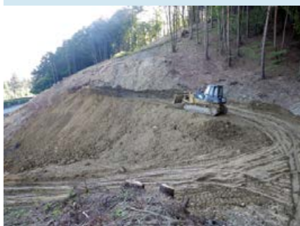
Na západnom portáli sa realizujú geodetické práce, svahovanie terénu a osadenie žľabov.
