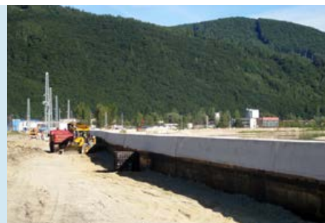
„Výrazné zmeny je možné vidieť aj na stavbe železničného spodku ŽST Považská Bystrica. Konsolidačná vrstva, odkop železničného spodku koľají č. 6, 8, ako aj betonáž základových pasov a osadenie nástupištných hrán,“ dopĺňa na záver nášho monitoringu prvej etapy odborný výklad J. Oláh.
