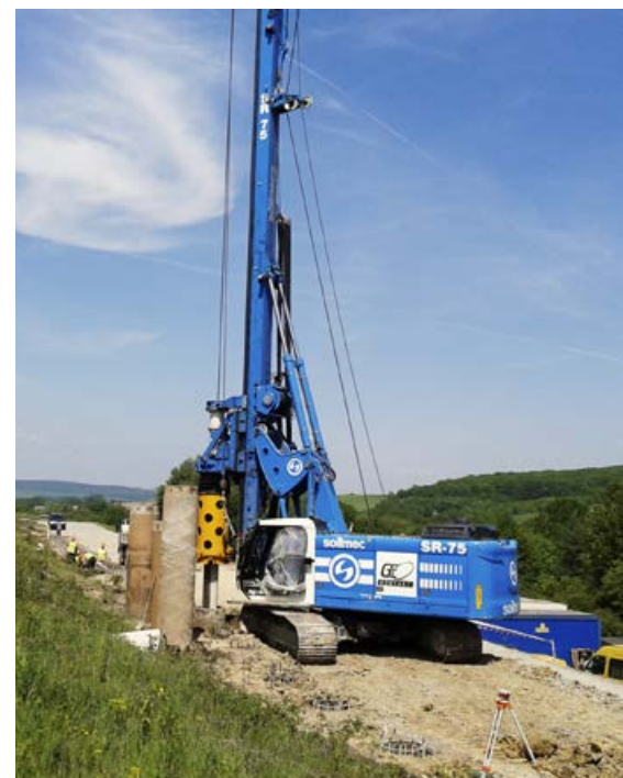
V úseku ŠRT v km 67,000 - 67,400 prispeje k stabilizácii úseku 253 betónových pilót.
