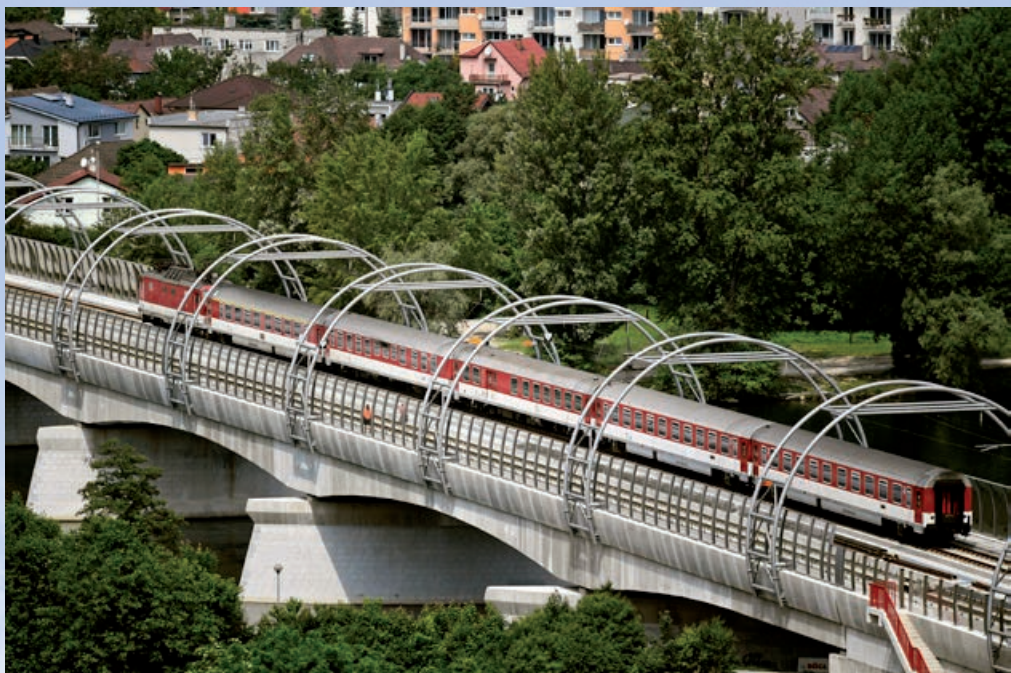
Na moste s dĺžkou 343 metrov je zabudovaná betónová pevná jazdná dráha systému RHEDA 2000. Vlaky po ňom môžu jazdiť rýchlosťou do 140 km/hod. Celková hmotnosť mosta je 54 834 ton.
