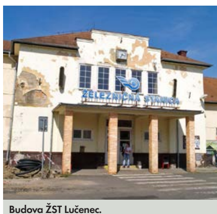
Budova ŽST Lučenec.
