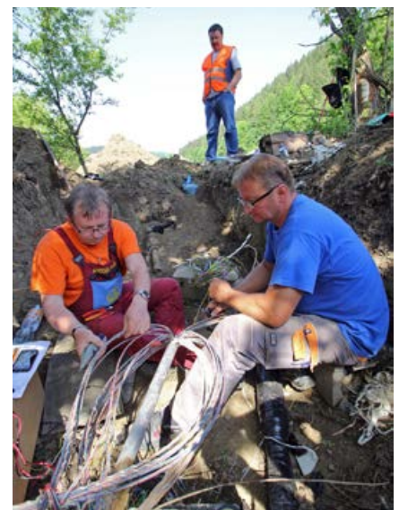
Ján Rybníkač, merací technik dodávateľa, meria parametre traťového kábla.
