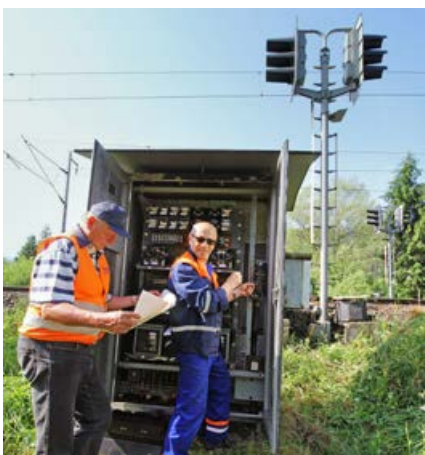
Ján Rybníkač, merací technik dodávateľa, meria parametre traťového kábla.
