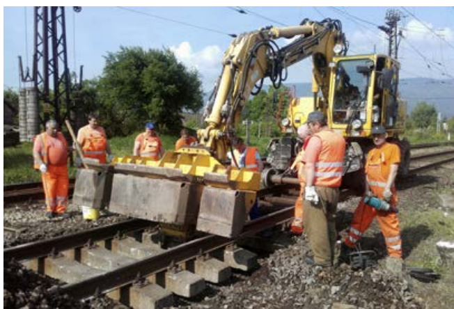
Oblúk medzi železničnou a nákladnou stanicou vo Vrútkach už dnes držia betónové podvaly z koľajových polí vyzískaných z koridoru.
