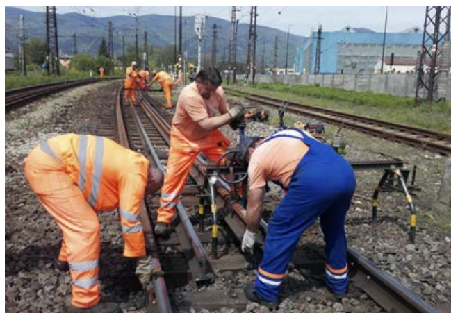
Zamestnanci SMSÚ ŽTS TO Vrútky menili v oblúku trate vo Vrútkach okrem podvalov aj koľajnicové pásy.
