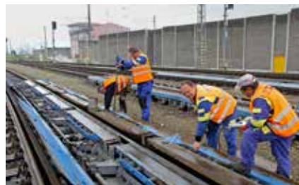
Cykly údržby 126 koľajových brzd sú rôzne. Kým dennú, týždennú a mesačnú kontrolu vykonávajú zamestnanci odvetvia OZT, polročnú už robí dodávateľská firma.
