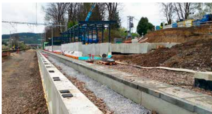
Realizácia montáže nástupištých dosiek. Rozprestretie a hutnenie násypového materiálu.
