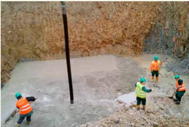
Betonáž podkladu na základovej škáre na moste v Nosiciach.
