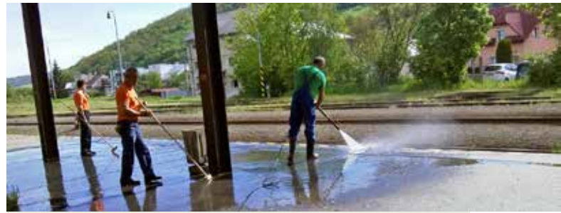
Pri čistení stanice a jej okolia prešovskí budovári a zamestnanci ŽST požívali aj vysokotlakový čistič a dezinfekčné prípravky.
