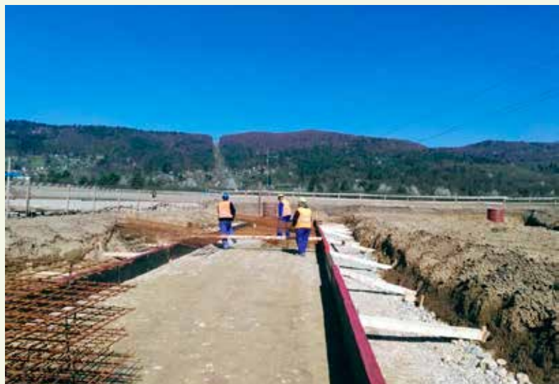
Armovanie a debnenie piliera podpery na novom železničnom moste nad Váhom.
