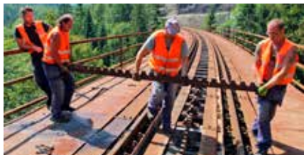
Na Čertovom moste boli v roku 2014 zrealizované opravy ozubnicovej trate, vďaka čomu dnes po tejto jedinečnej trati jazdí ozubnicový parný vlak.
