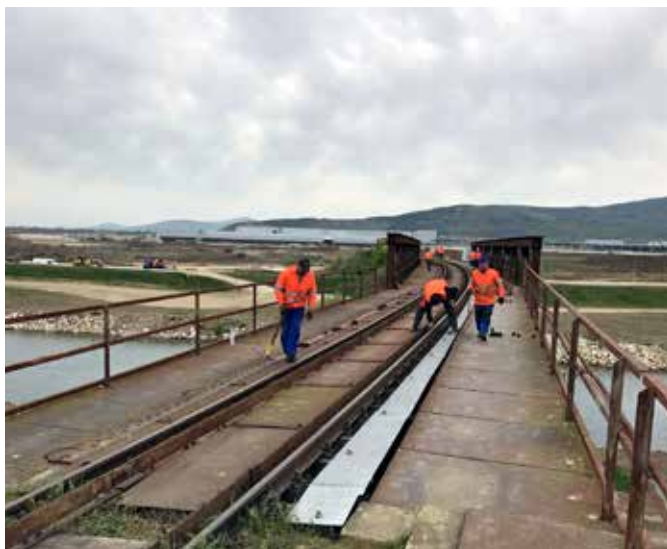
Súčasnou TIP Lužianky budú aj dva železničné mosty. Prvý, jestvujúci, sa už rekonštruje, druhý sa ešte len vybuduje.
