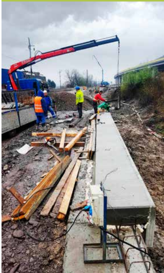
Realizácia montáže nástupištých dosiek. Rozprestretie a hutnenie násypového materiálu.
