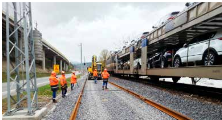
Dovoz koľajového kameniva v úseku Dolný Hričov - Žilina. Rovnanie a hutnenie koľajového lôžka. Realizácia drážky z dlhých koľajnicových pásov systému Donelli.
