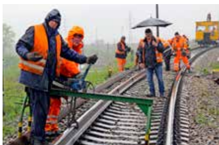
Žilinskí traťováci síce mali výluku dôkladne pripravenú, počasie si však nedokázali naplánovať. Výmenu koľajnice na spojovacej koľaji im sťažoval hustý lejak.
