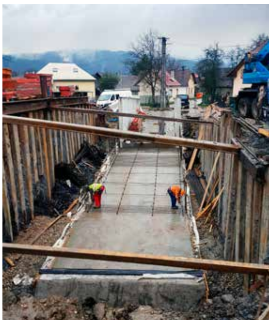
Práce na podchode pre cestujúcich na zastávke Horný Hričov, realizácia tesárskych, železiarskych a betonárskych prác a čerpacej šachty.
