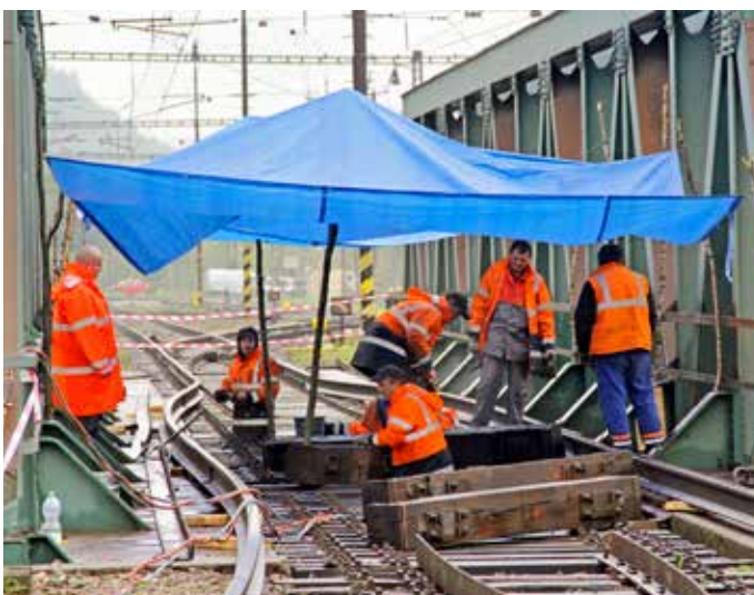
Opravu ocelevej konštrukcie mosta v zriaďovacej stanici Žilina vykonávali bratislavskí mostári aj v nepriaznivom počasi.
