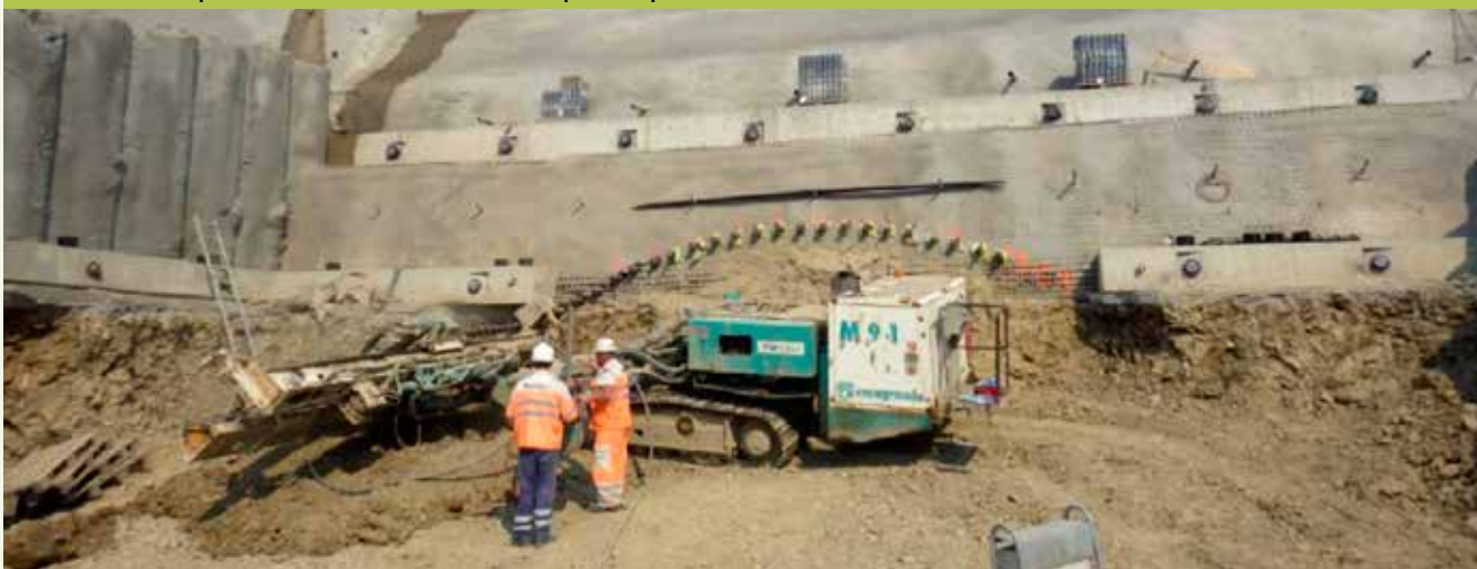
Realizácia 1. mikropilotového dáždnika tunela Diel na západnom portáli.
