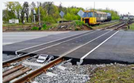
Na frekventovanom železničnom priecestí na Mierovej ulici v Strážskom zriadili prešovskí traťováci nové kolajové lôžko s novými kolajnicami a podvalmi.
