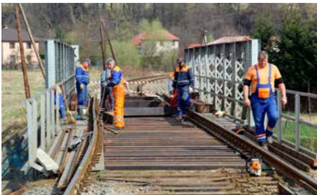
Jeden zo štyroch železničných mostov na Kysuciach, ktorý bratislavskí mostári opravovali. Na moste v km 9,720 vymieňali mostnice.
