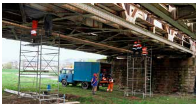
Ocelový, nitovaný, priehradový most s dolnou mostovkou, ktorý pozostáva z dvoch mostných otvorov a premoštuje rieku Hornád, čaká rozsiahla rekonštrukcia.
