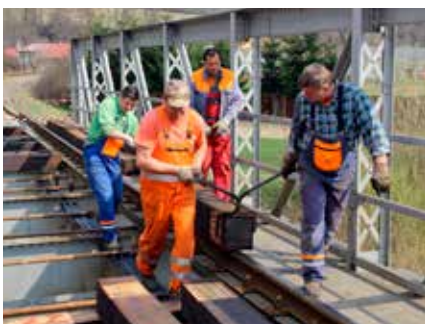
Presun a manipulácia s ťažkými mostnicami na otvorenej ocelevej konštrukcii mosta je mimoriadne náročná fyzická práca.
