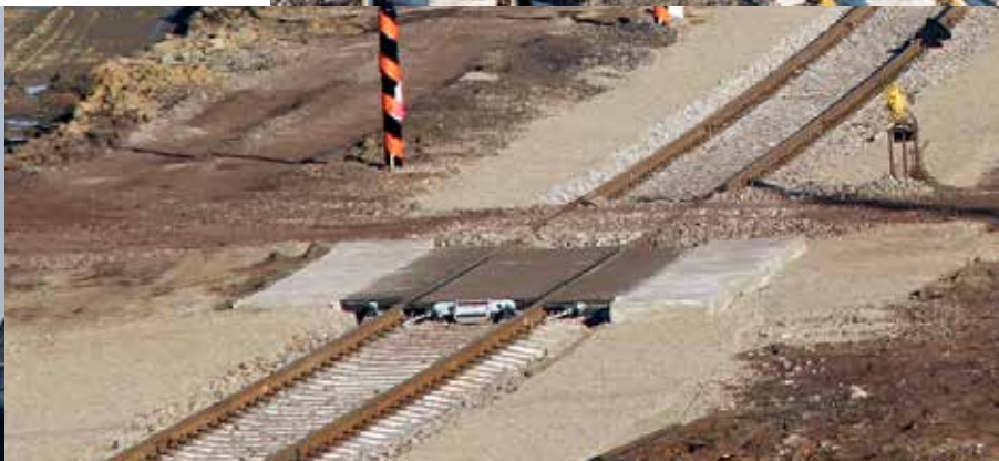
Súčasnou modernizáciou sú nové koľaje širokého a normálneho rozchodu. Na koľajach križujúcich vnútroareálové komunikácie sú umiestnené nové priecestné konštrukcie.
