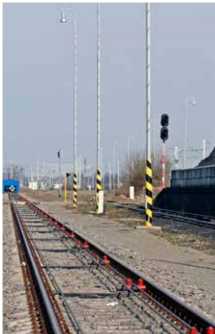
Súčasnou modernizáciou sú nové koľaje širokého a normálneho rozchodu. Na koľajach križujúcich vnútroareálové komunikácie sú umiestnené nové priecestné konštrukcie.
