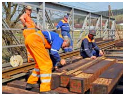
Každá mostnica je spracovaná individuálne, presne na určené miesto na mostnej konštrukcii. Aby ich mostári nepoplietli, označia ich číslom.
