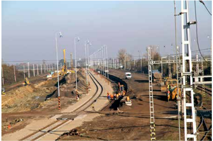
Modernizácia infraštruktúry v Čiernej nad Tisou začala v roku 2014. Na fotografii sme zachytili stavebný ruch v novembri 2015.
