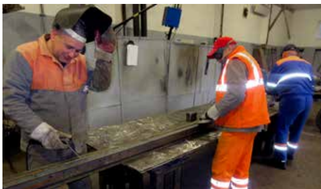
Mostári v dielňach vyrábajú konštrukčné prvky mostov určené na výmenu. V tomto prípade priečne stuženia hlavných pásov priehradových konštrukcií.
