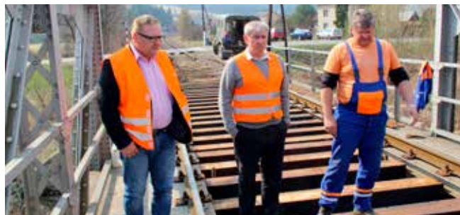
Odhliadnuc od rozsiahlej výlukovej činnosti na modernizovanom železničnom koridore, oprava kysuckých mostov bola prvá významnejšia akcia v obvode OR Žilina. To bol dôvod, prečo ju osobne navštívil aj riaditeľ OR Žilina Andrej Marcinko (v strede) a žilinský námestník riaditeľa OR pre riadenie dopravy Peter Blaho (vľavo). Postup prác na moste v km 9,720 im vysvetľuje majster SMÚ MO Žilina Luboš Hlaváč.
