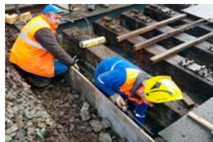
Po odbúraní poškodeného záverného múrika v koľaji na moste, uložení a upevnení kovovej armatúry, osádzajú tesári SMÚ MO Žilina Milan Briš a Matúš Krasňan debnenie na betonáž nového múrika. Foto: Miroslav MEDVEČKÝ
