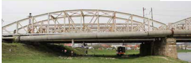
Ocelový, nitovaný, priehradový most s dolnou mostovkou, ktorý pozostáva z dvoch mostných otvorov a premoštuje rieku Hornád, čaká rozsiahla rekonštrukcia.
