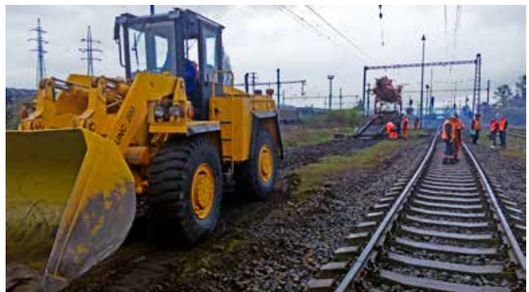
Počas prvých väčších tohtoročných opráv košickí traťováci zrekonštruovali koľajové lôžka a vymenili koľajové rošty v Haniske pri Košiciach, Čečejevciach aj Jablonove nad Turňou.
