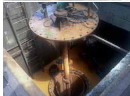
Ochrana podzemných vôd v Čiernej nad Tisou pozostáva z 12 ks čerpacích vrtov a ďalších súčastí, ktoré odčerpávajú znečistený podzemný vodu spod koľajiská.
