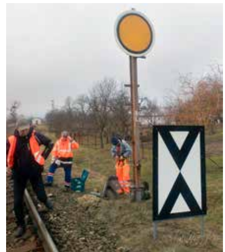
Zhasnutú predzvesť dočasne nahradil terč s reflexnou úpravou, znázorňujúci trvalú návěst „Výstraha“. Namontovali ho 9. marca zamestnanci SMSÚ OZT SO Spišská Nová Ves.
