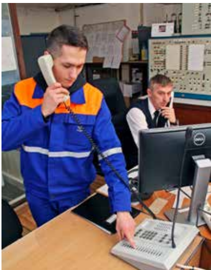
Dominik Timko v dopravnej kancelárii vykonáva funkčnú skúšku dopravných telefónnych okruhov na dispozičnom zapojovači MIKRO od firmy INOMA COMP s. r. o., ktorý je potrebný aj pre službukonajúceho výpravcu Radoslava Kišša (napravo). Umožňuje výpravcovi spojenie so signalistami, dispečermi a výpravcami v susedných dopravných priestoroch pri riadení vlakovej dopravy.
