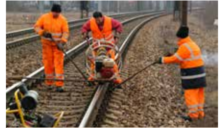
Pri použití napínacieho zariadenia musí byť koľajnicový pás uvoľnený, aby sa mohol plynule predĺžovať.
