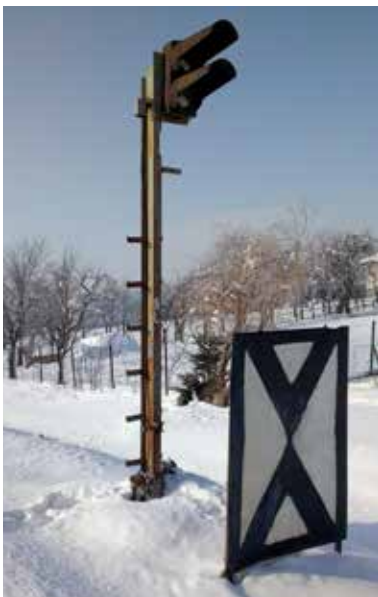
Svetelná predzvesť v ŽST Dlhé nad Cirochou je atypická, skonštruovaná „na kolene“, na pôvodnom stĺpe mechanickej predzvesti. Závesný kábel, ktorý privádzal elektrickú energiu, v januári ukradli zlodeji. Odvtedy je ponorená v tme.
