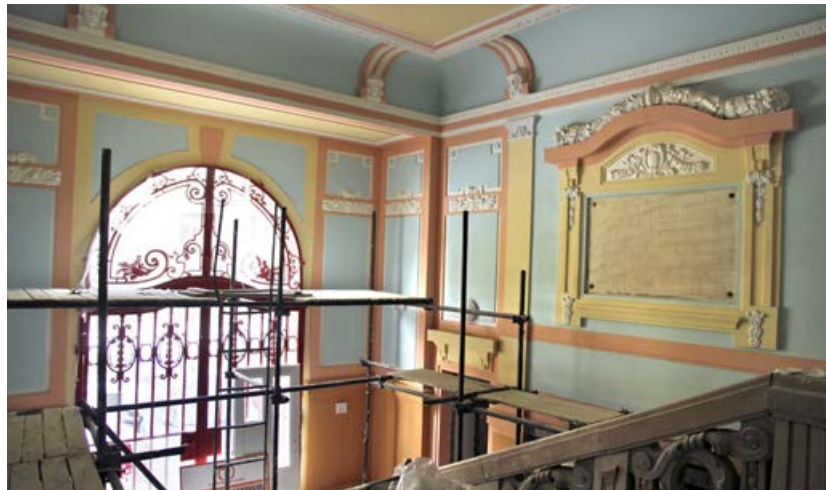
Reštaurátorské práce sa týkajú aj vnútornej štukovej výzdoby vo vstupnej hale, na schodiskách a v rokovacích priestoroch.
