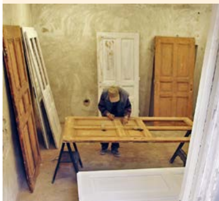
V železničnej budove bolo remeselne obnovených 507 pôvodných dverí a zárubní.
