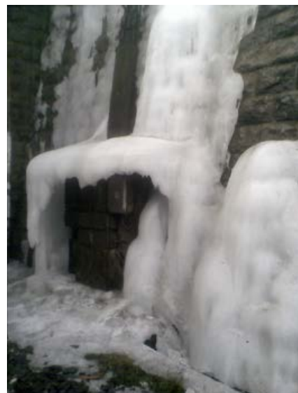
Otlkanie ľadu je v Jablonoskom tuneli v týchto dňoch dennou činnosťou traťových a tunelárov.
