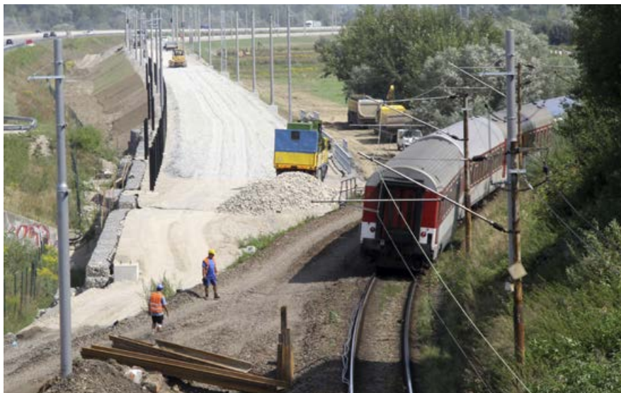
Vo viacerých stavebných úsekoch začnú v tomto roku práce na preložkách pôvodných traťových kolají a narovnávaní oblúkov trate.
