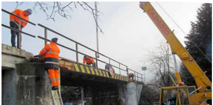
Oceľovú zábranu upevnili na pôvodnom mieste zamestnanci MO Košice.
