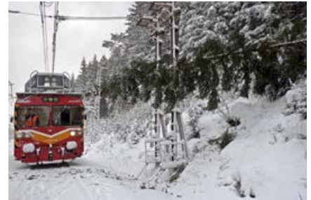
Následkom výdatného hustého sneženia a silného vetra v lokalite Hybe došlo k vyvráteniu stromov do priečného prierezu železničnej trate.
