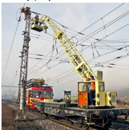
Elektrikári musia vystúpiť až na vrchol stožiara, aby mohli vymeniť úsekový odpájač.
