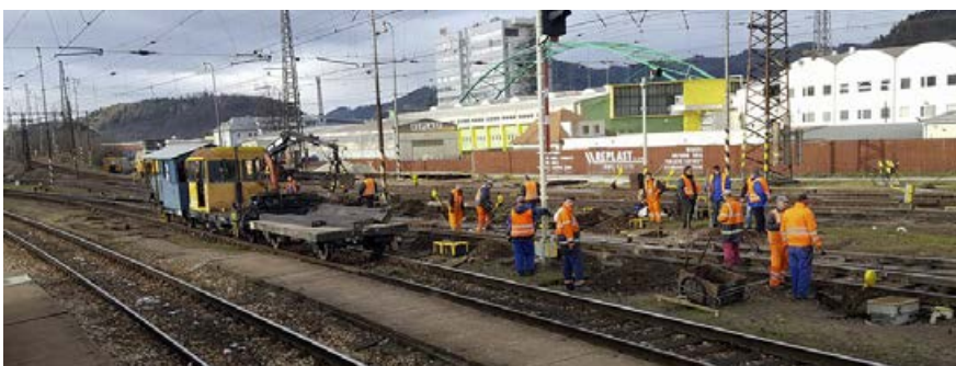
Zamestnanci SMSÚ ŽTS TO Žilina začali s opravou poškodených výhybiek hneď na druhý deň zrána a skončili 28. novembra o 15.00 hod.
