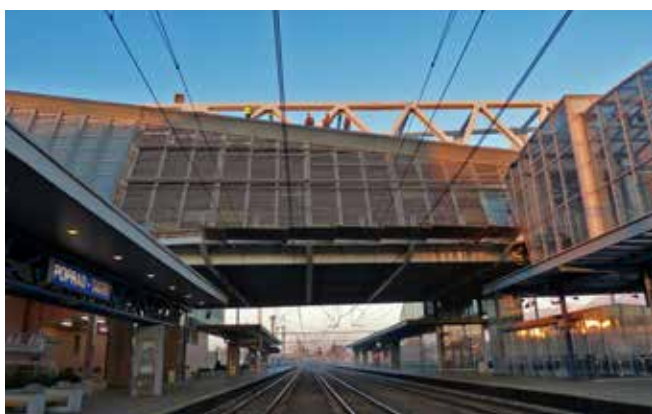
Tento pohľad na prestupovu halu bude už čoskoro minulosťou. Nové preklenie a nátery konštrukcie budú pôsobiť oveľa estetickjšie.
