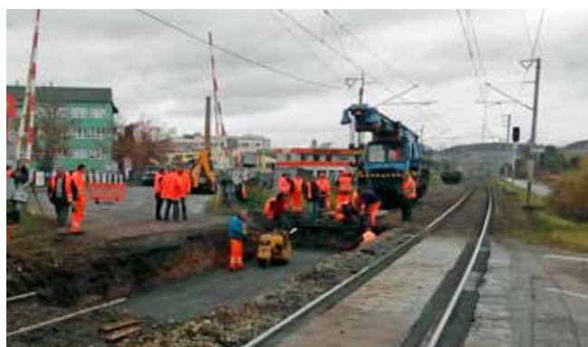
Rekonštrukčné práce na železničnom priecestí v Spišskej Novej Vsi na Markušovskej ceste sa realizovali postupne, vždy len na jednej koľaji, aby bol dopad na železničnú dopravu čo najmenší. Foto: Štefan MORE
