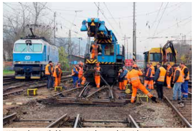
Križovatková výhybka pozostávala z troch častí, ktoré sa po oprave postupne ukladali na pôvodné miesto. Práce sa diali za plnej prevádzky na susedných koľajach.
