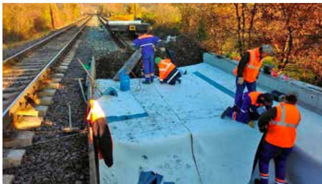
V priebehu dvoch mesiacov mostári na trati Púchov – Lúky pod Makytou šesťkrát pokladali izolačné fólie.
