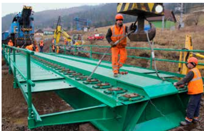
Mostári svoju činnosť pomaly končia. Nastúpia pripravení traťováci na zriadenie koľajového lôžka a uloženie koľajnic.
