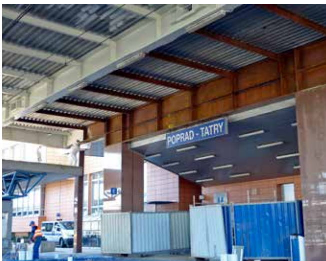
Zrekonštruovaná oceľová konštrukcia na prestupovej hale má už dnes svoje nové nátery.
