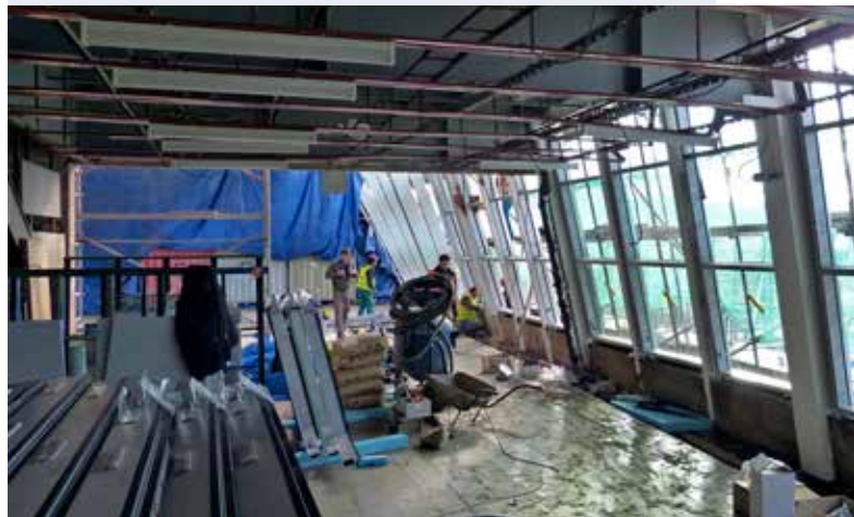
Samotná rekonštrukcia prestupovej hale si vyžiadala demontáž pôvodných vrstiev strechy od dilatácie a následné zhotovenie novej strechy, vrátane tepelnej izolácie. Demontovali sa staré žalúzie a zasklenia.
