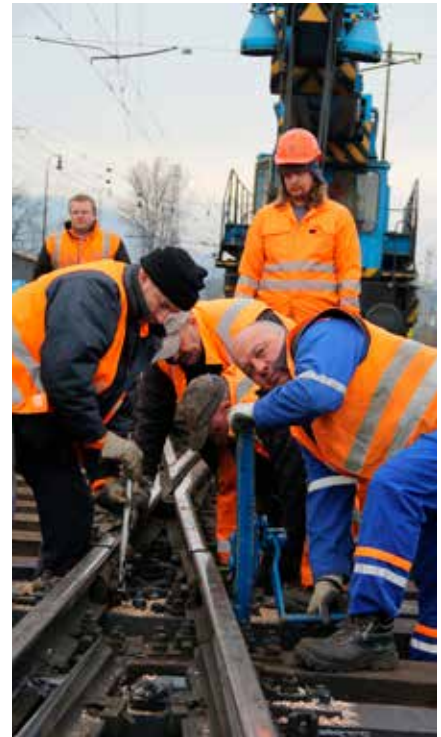
Jednotlivé diely výhybky spájali zámočníci koľajových konštrukcií SMSÚ ŽTS TO Žilina.
