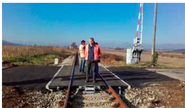
Hotové priecestie z celogumových panelov STRAIL. V popredí Vladimír Čeman, koordinátor SMSÚ ŽTS TO Jesenské.
