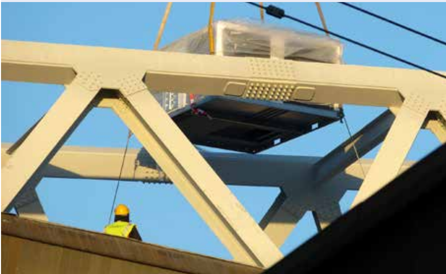
Vyšlo to presne podľa plánov a s absolútnou presnosťou sa podarilo zložiť ťažké klimatizačné zariadenia v hale TEŽ na určené miesto. Celá akcia trvala 20 minút, presne podľa plánov sa to stihlo vo vlakovej prestávke.
