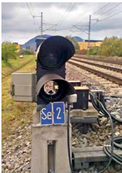
Pri poškodení návestidla takmer vždy dôjde k rozbitiu priehľadného skla, tzv. Fresnelovej šošovky a farebného filtra.
