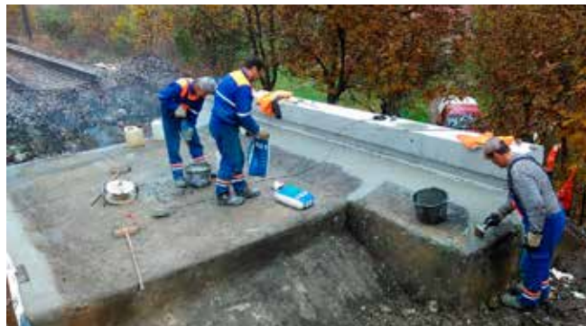
Súčasťou prác bola aj oprava poškodených betónových častí mostných objektov.
