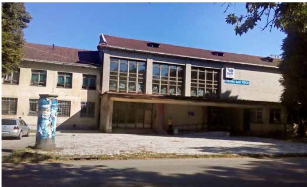
Čierna nad Tisou je významným železničným uzlom na ukrajinskej hranici, keďže ide o najväčší suchozemský prístav na Slovensku. Komplexná rekonštrukcia staničnej budovy je zaradená v pláne na roky 2016 – 2019.
