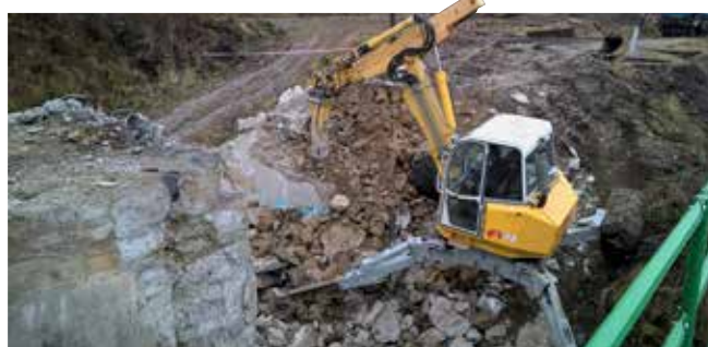
Najprv bolo potrebné rozobrať koľaj a vybagrovat koľajové lôžko, aby bolo možné osadiť mostné provizórium.
