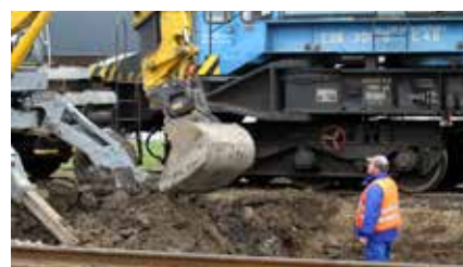
Odstraňovanie starého štrkového lôžka bagrovaním a jeho vývoz na skládku sa robí počas prvých dní výluky presne podľa plánu aj napriek nepriazni počasia.
