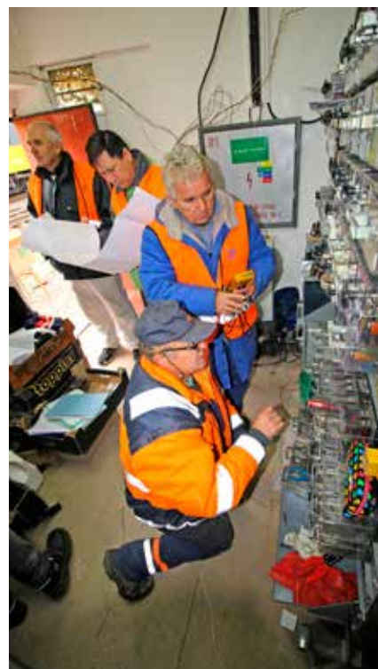
Množstvo práce sa odvieďlo v reléovom domčeku, v ktorom zamestnanci odvetvia OZT zapájali nový reléový stojan, určený na ovládanie priecestia.
