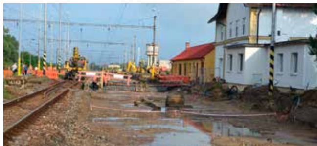
V letných mesiacoch sa koľajisko ŽST Jablonica zmenilo na veľké stavenisko.
