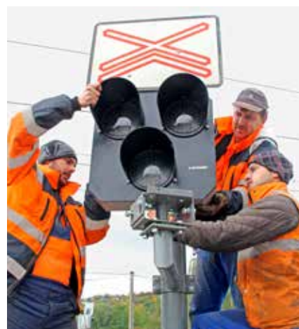
Zľava Martin Duško, Miroslav Melega a Patrik Rybár umiestňujú na stojan nový skriňku výstražníka s LED svetlami.
