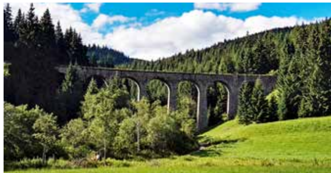
Najzaujímavejšou mostnou stavbou tohto úseku je Telgártsky viadukt v stavebnom km 9,442. Je 86,2 m dlhý, 22 m vysoký a leží v priamej trati so sklonom 17 ‰.
