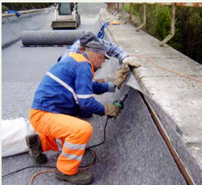
Košičkí mostári z margecianskeho pracoviska obnovili hydroizoláciu na jednokoľajnom klenbovom moste neďaleko zastávky Stará Voda.
