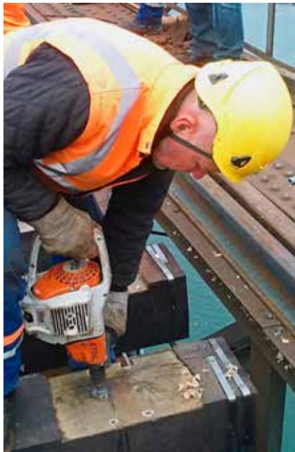
Jozef Urban z MO Bratislava SMÚ Zvolen frézuje na úložnej ploche mostnice zápusťné otvory na hlavy nitov.
