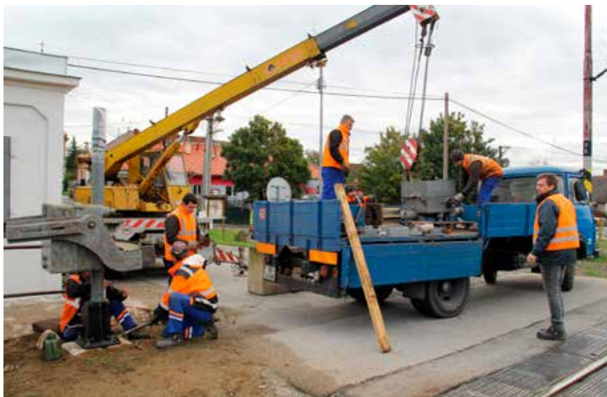
Na výmene vonkajších prvkov zabezpečovacieho zariadenia na priecestí v Ťahanovciach sa podieľali najmä zamestnanci SMSÚ OZT SO Spišská Nová Ves. Pôvodné stojany so závorami nahradili repasovanými a vybavili ich LED výstražníkmi.
