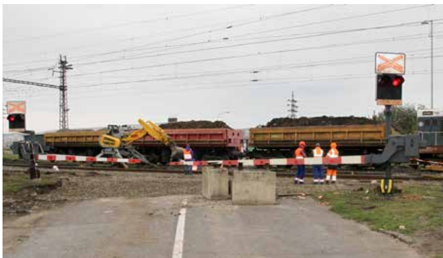
Komplexná rekonštrukcia frekventovaného košického priestestia si vyžiadala úplne odstavenie prejazdu.
