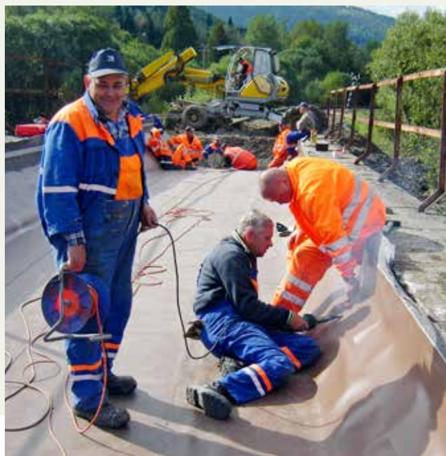
Košičkí mostári z margecianskeho pracoviska obnovili hydroizoláciu na jednokoľajnom klenbovom moste neďaleko zastávky Stará Voda.
