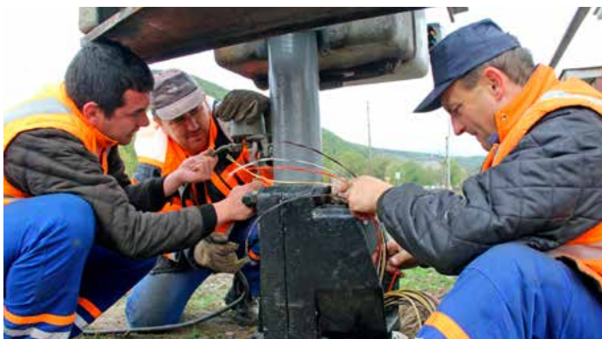
Po osadení stojana bolo nevyhnutné jeho oživenie. Naľavo zabezpečovacia a oznamovací elektromechanik Rudolf Roth a prevádzkový zámočník Miroslav Melega montujú vodič ukoľajnenia, zabezpečovací a oznamovací elektromechanik Ján Uhrin zapája kábel do svorkovnice.
