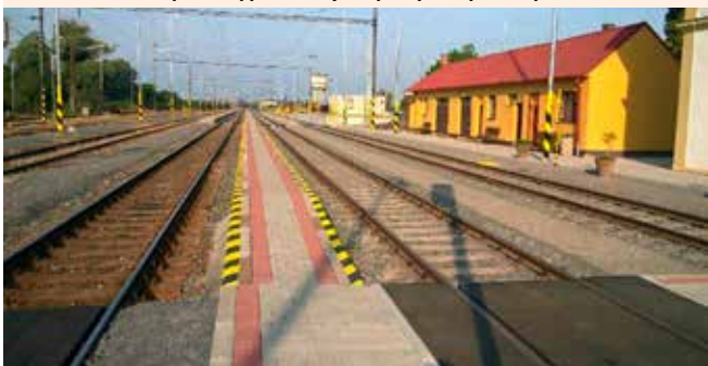
Obnovené nástupišť a priechody zlepšili prístup cestujúcich k vlakom.
