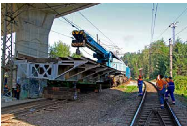
Most mal najviac poškodené krajné priečne stuženia pri oporách, ku ktorým by sa mostári z MO Bratislava bez vybratia mostnej konštrukcie nedostali.
