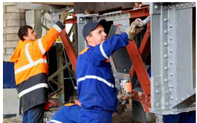
Práce na moste finišovali nanosením ochranných náterov.
