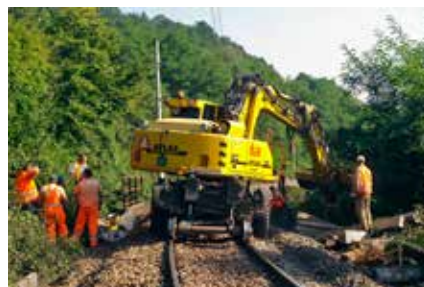
V septembrovej výluke na trati Hronský Beňadik – Nová Baňa bolo potrebné vymeniť poškodené podvaly.
