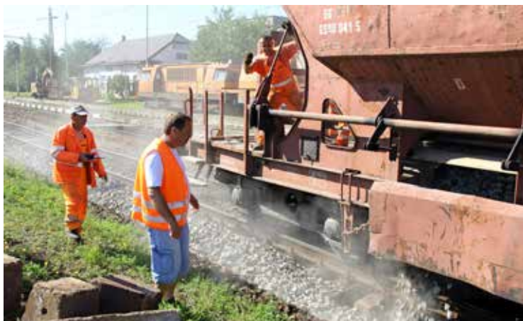
Dopĺňanie štrku pred podbitím koľaje pozorne sledoval a riadil koordinátor SMSÚ ŽTS TO Košice Štefan Ludvik (druhý zľava).
