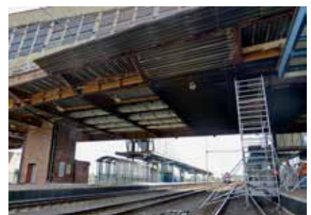
Stavbári rozoberajú v súčasnosti podhľad nad nástupiskami. Foto: Martin ČECH
