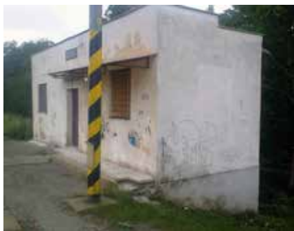
Brekov pred opravou...
