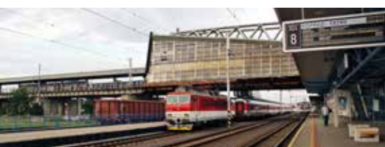
O necelý rok by mal byť takýto pohľad omnoho krajší, keďže III. etapa modernizácie popradskej stanice by mala byť ukončená a hala TEŽ zrekonštruovaná.
