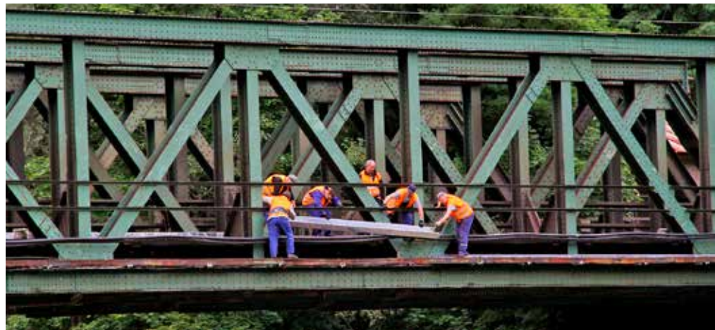
Montáž káblovej chráničky si vyžadovala veľkú opatrnosť, keď že ju chlapi dodávateľa umiestňovali z vonkajšej strany železničného mosta.
