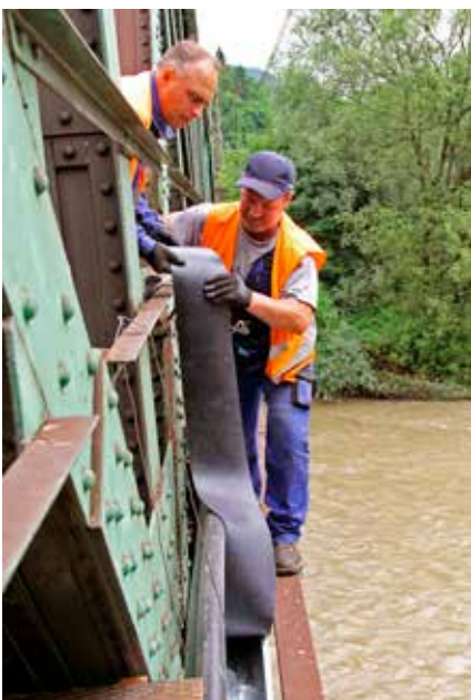
Vnútro kovovej chráničky vystýla gumená podložka, na ktorú sa uložili káble. Až potom ju zamestnanci Betamontu mohli uzavrieť.
