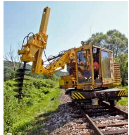
Vítanie, osadzovanie a betónovanie zaisťovacích značiek v úseku trate Snina – Stakčín koľaj č. 1 od km 22,300 – 27,245.
