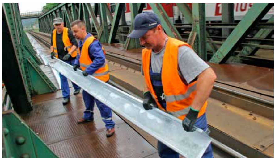
Výmena chráničky sa realizovala počas štyroch denných výluk 1. traťovej kolaje medzistaničného úseku Kralovany – Lubochňa.
