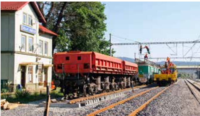
Až do 13. septembra prebieha v Dolnom Hričove modernizácia párnej skupiny staničných koľají.
