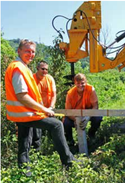
Zľava: Peter Maurer, správca ŽI, majster Miroslav Zinčák a kontrolór Dávid Suchý pri osadzovaní zaisťovacej značky pred zabetónovaním.
