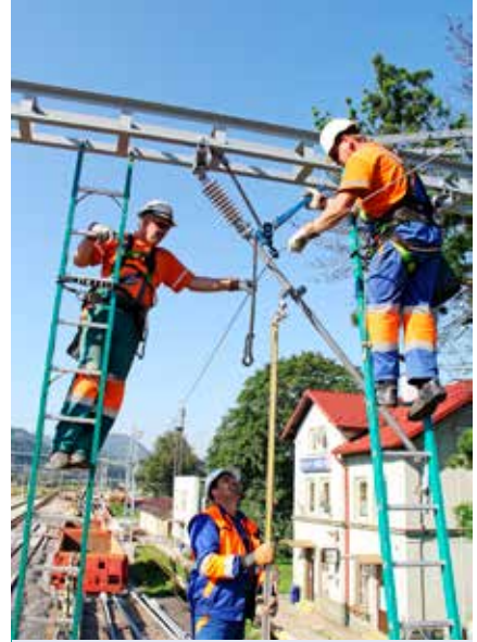
Trakčné laná montujú pracovníci EŽ Praha. Po ukončení elektrifikačných prác v ŽST Dolný Hričov zostane naďalej trakčná jednosmerná prúdová sústava 3 kV, ale trakčná zostava bude maximálne pripravená na zmenu prúdovej sústavy na striedavú trakciu 25 kV 50 Hz.
