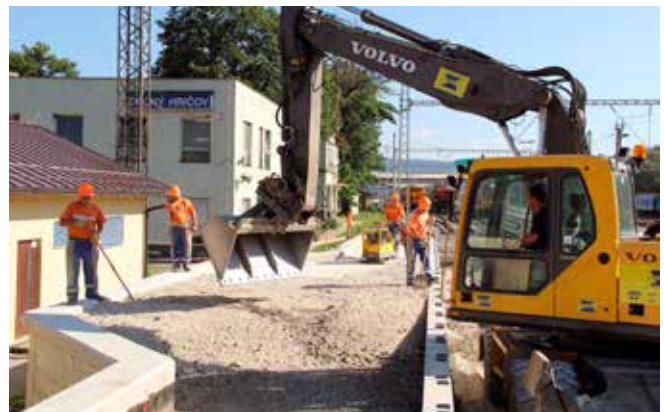
Pracovníci TSS Grade realizujú zásyp nástupišťa č. 2 pri 4. staničnej koľaji. Horná povrchová úprava nástupíšť je riešená štandardne - zámkovou dlažbou s výstražným a vodiacim pásom pre osoby so zrakovým postihnutím.
