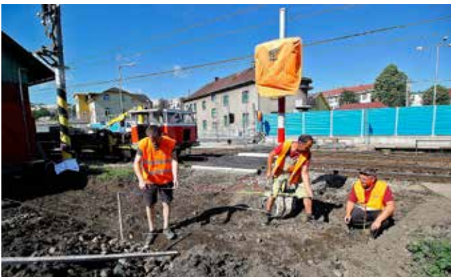
Súčasťou obnovy priecestia bolo aj vybudovanie prístupových chodníkov.
