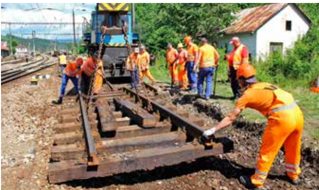
Zamestnanci SMSÚ ŽTS TO Žilina využili výluku určenú na sprevádzkovanie priecestia a v stanici Čadca zrušili jednoduchú výhybku na koľajách do depa, ktorú nahradili koľajovým poľom.
