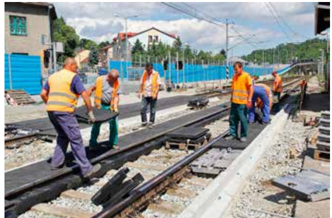
Na priecestí aj priechode pre peších sa montovala celogumová priecestná konštrukcia typu STRAIL.
