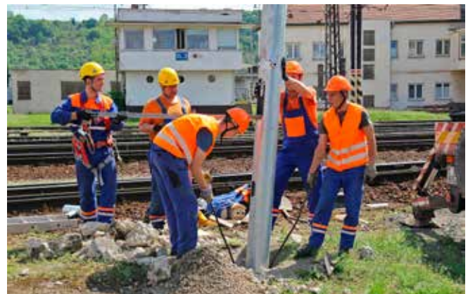
Sklápací stožiar musí presne sadnúť do pripraveného základu.
