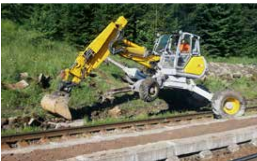
Menzi - muck pri práci v tretej koľaji železničnej stanice Štrba.
