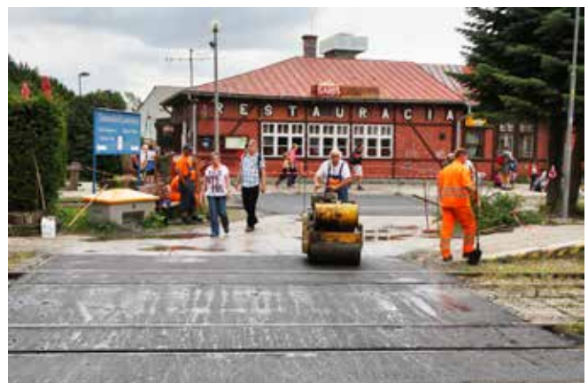
Spevnenie priechodu vykonali traťováci konštrukciou zhotovenou zo starých koľajnic.
