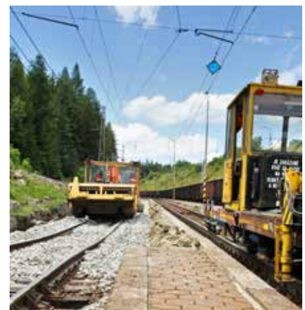
Úprava geometrickej polohy koľaje v ŽST Štrba.
