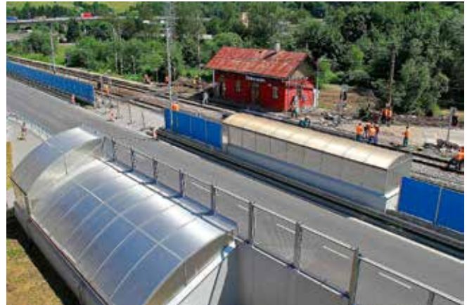
Pri sprejzdnení obchádzkovej trasy cez obnovené priecestie bolo potrebné odstrániť aj časť protioslňujúcej steny.
