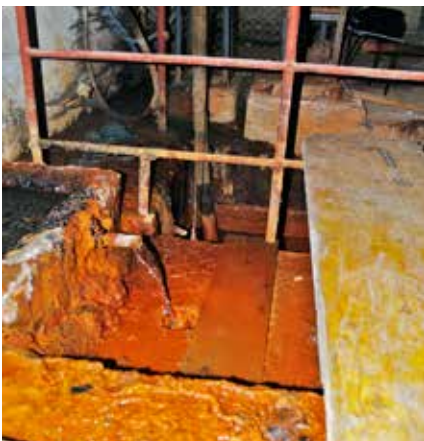
Jeden z prameňov vyviera v suteréne pod stanicou. Vodu je potrebné neustále odčerpávať, inak hrozí zaplavenie.
