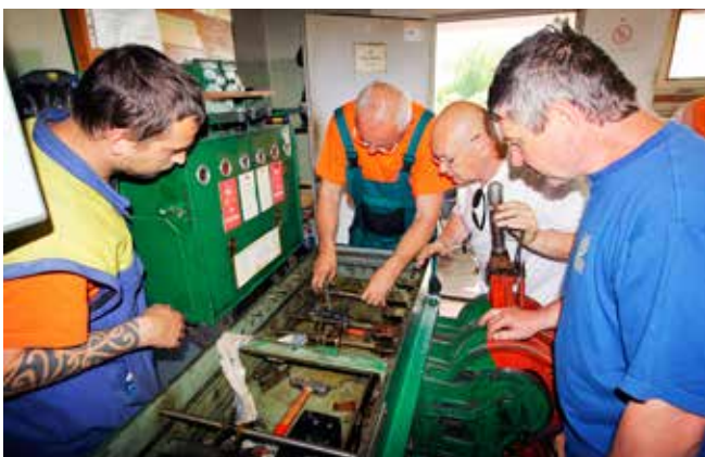
Výmenu návěstidiel a úpravu stavadlových prístrojov vo Veľkom Horeši realizovala firma AŽD, a. s., Bratislava.
