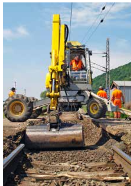
V mieste priecestia sa muselo koľajové lôžko prečistiť s následnou úpravou geometrickej polohy koľaje.
