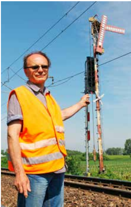
Michal Ihnát ukazuje na neplatné vchodové mechanické návěstidlo. Počas výluky bola aktivovaná jedine svetelná privolávacía návěšť, aby signalista nemusel zakaždým chodiť k blížiacemu sa vlaku s ručnou privolávacou návěšťou. Po ukončení výluky už fungovali všetky svetelné návěšti.
