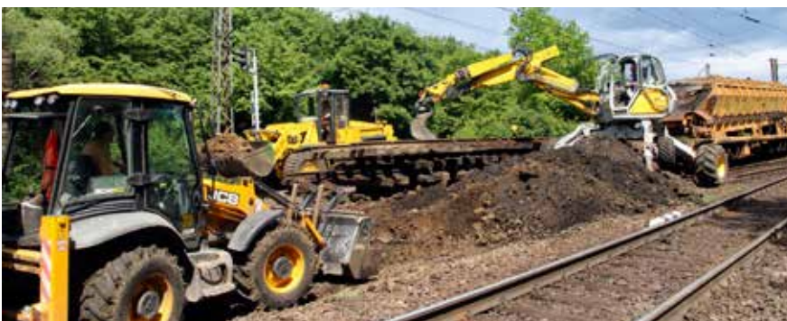
Odstránenie a vyčistenie koľajového lôžka si v Ruskove vyžiadali súčinnosť viacerých strojov.
