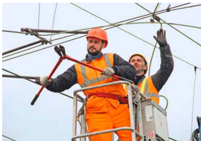
Elektromontéri Marián Timko a Tomáš Poľák pri strihaní trolejového drôtu.
