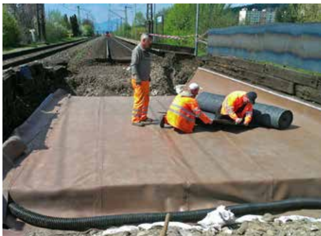
Pri zastávke Okoličné mostári vymenili hydroizoláciu na dvoch betónových mostoch pod 2. traťovou koľajou.
