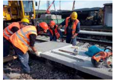
Pôvodné nástupiska typu Tischer nahradili typom SUDOP s protišmykovou povrchovou úpravou.
