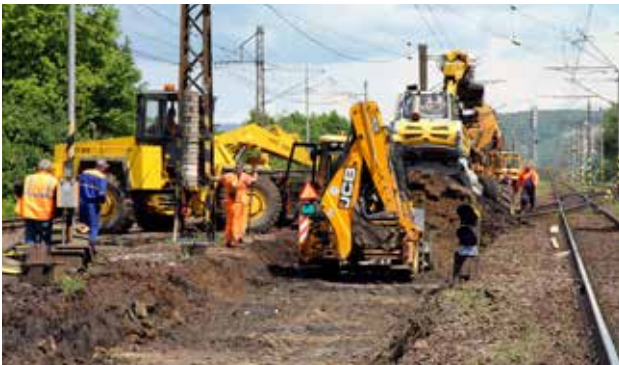
Traťováci z SMSÚ ŽTS TO Košice, pracovisko Barca, za výdatnej pomoci strojovej mechanizácie z MDS Košice, Spišská Nová Ves a Štrba odstraňovali v Ruskove zlý technický stav koľaje č. 2. počas týždňovej výluky.
