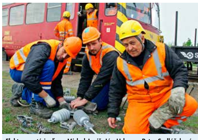
Elektromontéri, zľava Michal Janič, Ján Urban a Peter Sedláček nám zapozovali pri kompletizácii izolátorov pre nové zosilňovacie vedenie.
