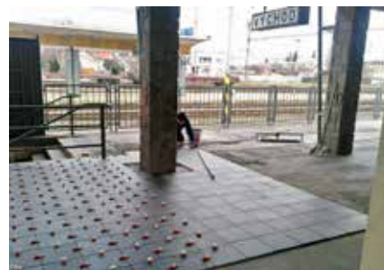
Nová keramická dlažba zvýšila okrem estetického hľadiska aj bezpečnosť.
