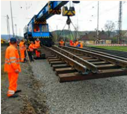
V rámci výluky traťováci z SMSÚ ŽTS TO Spišská Nová Ves vymenili aj chybné koľajnice.
