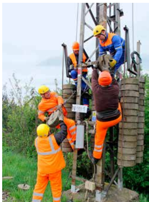
Pri demontáži nepotrebného vedenia sa rušilo aj jeho pohyblivé vykotvenie na trakčnej podpere. Trolejári preto odstraňovali prebytočné závažia.
