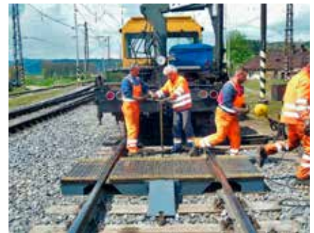
Rekonštrukciou prešiel aj služobný prechod.
