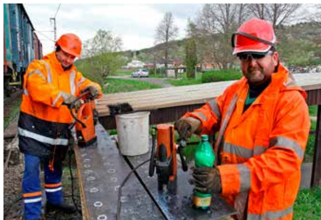
Ján Timko, Ondrej Šofranko mostári z SMÚ MO Margecany, pomocou špeciálnych magnetických vŕtačiek s korunkovými vrtákmi robia do pásnic otvory pre nity.
