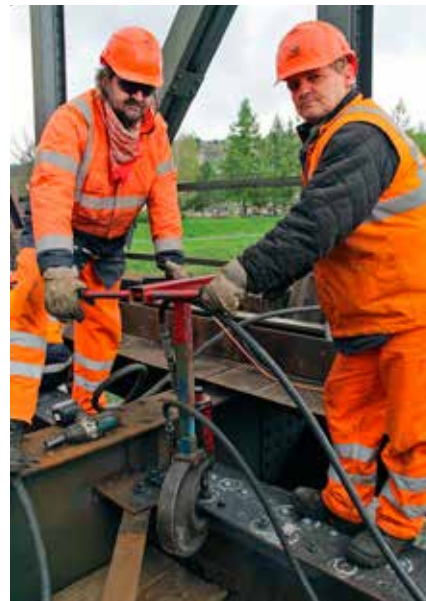
Marek Hleba, Peter Franko nitujú pásnice k pozdĺžnikom pomocou nitovacej hydraulické jednotky.
