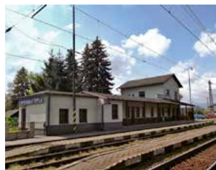
Staničná budova vyzerá zachovalá, keďže prešla rekonštrukciou pred približne 15 rokmi.
