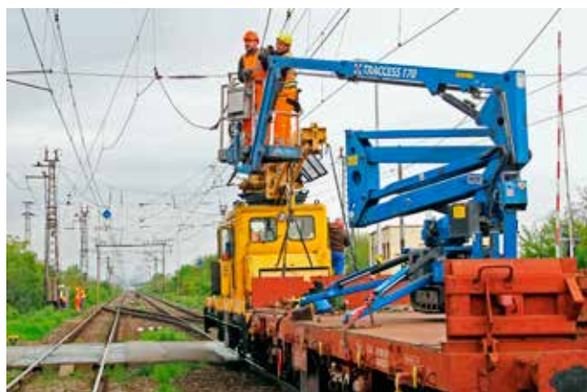
Trolejári z SMSÚ EE TV Trebišov demontovali trolejové vedenie nad nevyužívanou koľajou.
