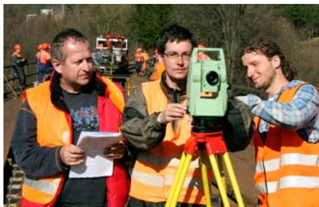
Na správne parametre jazdnej dráhy Handlovského viaduktu dozerali (zľava) Michal Hojčka, Roman Hazucha a Tomáš Murín, geodeti zo SŽG Bratislava.
