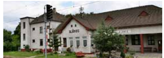
Slanec leží na trati Košice – Čierna nad Tisou. Na fotografii je pôvodný stav, so starou strechou...
