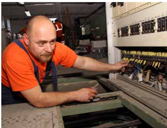
Peter Ignác počas demontáže pôvodného rozvádzača odpája nepotrebné vodiče káblov.
