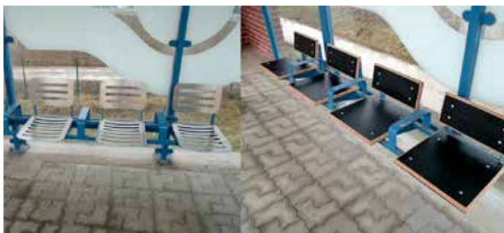
Pôvodné lavičky v presklených prístreškoch, inštalované počas modernizácie stanice, dlho na svojom mieste nepobudli. Vandali ich vytrhali rad radom, preto ich správca nahradil dreveným variantom.
