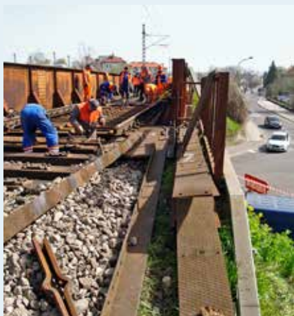
Košickí mostári mali pod palcom práce na moste.
