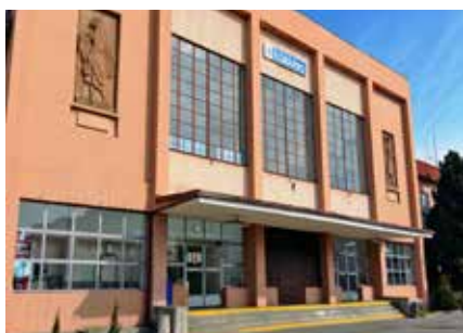
Stanica v Komárne čaká na výmenu okien.
