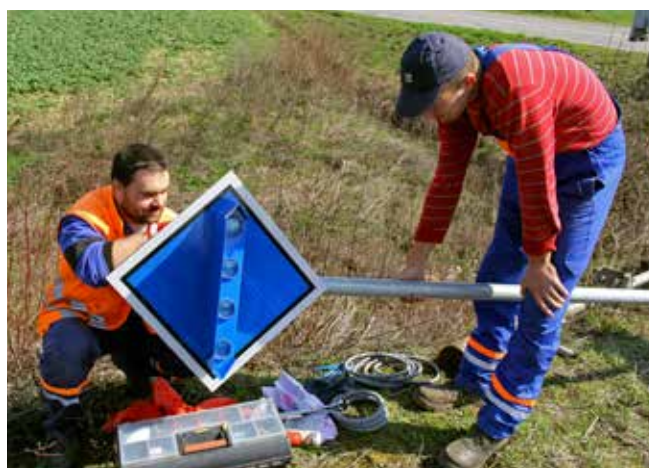
Elektromontéri SMSÚ EE TV Trebišov, zľava Marcel Bedri a Michal Janič montujú nový návěstný znak.
