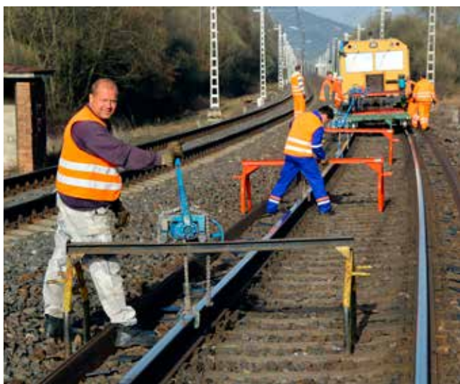
„Kozy“, ako traťováci slangovo nazývajú prekládkové žeriavy, sú určené na manipuláciu s dlhými koľajnicovými pásmi.
