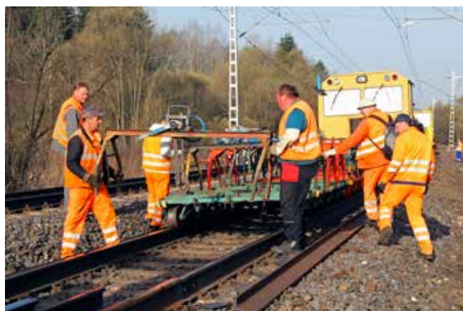
Kozy sú prepravované na špeciálnych, tzv. Mamatejových podvozkoch, čo sú zariadenia na prepravu koľajnic.
