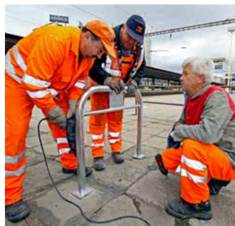
Cyklostojany osadzujú mostári spoločne s traťovákmi.
