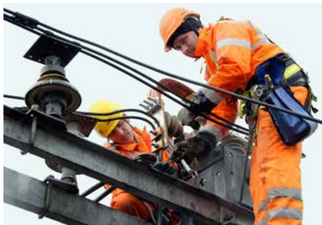
Štefan Kaško a Norbert Pribék, elektromontéri zo SMSÚ EE TV Trebišov, na vrchole stožiaru trakčného vedenia montujú nový úsekový odpájač. Služi na spínanie elektrických úsekov trolejového vedenia, v tomto prípade ŽST a širšej trate.
