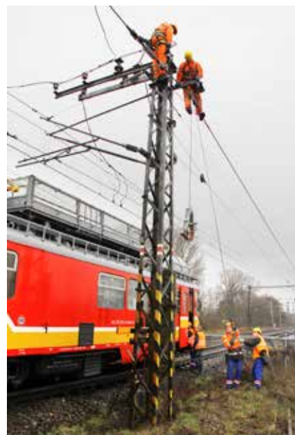
Miestami tepelných porúch sú najčastejšie skrútkové svorky a lisované spoje vedení. V Stred nad Bodrogom vykazoval vysokú teplotu úsekový odpájač, preto ho zamestnanci SMSÚ EE TV Trebišov vymenili.
