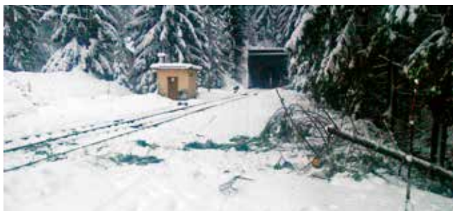
Voľnosť vlakovkej cesty môžu narušiť nielen koľajové vozidlá, ale aj iné okolnosti z vonkajšieho prostredia. Výpravca ŽST Čremošné 13. februára 2016 spozoroval spadnutý strom krížom cez hlavnú koľaj od ŽST Harmanec jaskyňa, za úrovňou vchodového návěstidla. Rušňovodič vlaku dopravcu RegioJet bol dispečerom včas vyznamenaný o prekážke na trati a bezpečne zastavil pred ňou.
