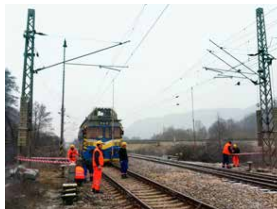
Pracovníci sekcie EE VVÚŽ, z pracoviska vo Vrútkach, v spolupráci s pracovníkmi SMSÚ EE TV Zvolen inštalujú deliče napätia na meranie potenciálu TV a ostatnú meraciu techniku počas plánovanej napäťovej výluky.
