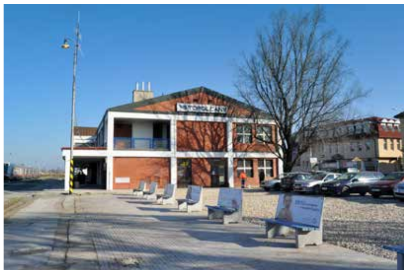
Plocha po asanácii bola upravená navážkou kameniva.
