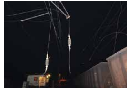
V Turanoch bolo poškodené trolejové vedenie medzi trakčnými podperami č. 13 až 19, štyri dolné a jedno horné smerové lano, 4 bočné držiaky, 20 trolejových vešiakov a ďalšie komponenty trolejovej sústavy.
