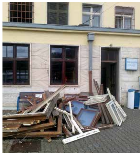
Budova železničnej stanice v Banskej Bystrici mala až do terajšej výmeny okien tie pôvodné, z roku 1952.
