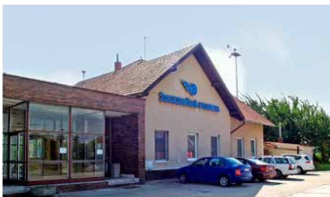
ŽST Kozárovce pred rekonštrukciou fasády a výmenou strešnej krytiny.
