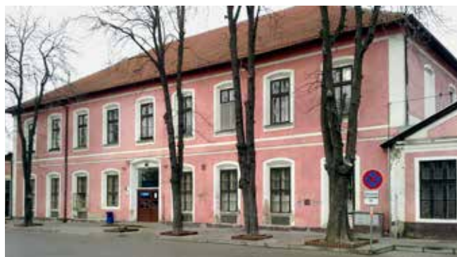
Výmena strechy a úprava fasády tejto stanice bola realizovaná v roku 2000.
