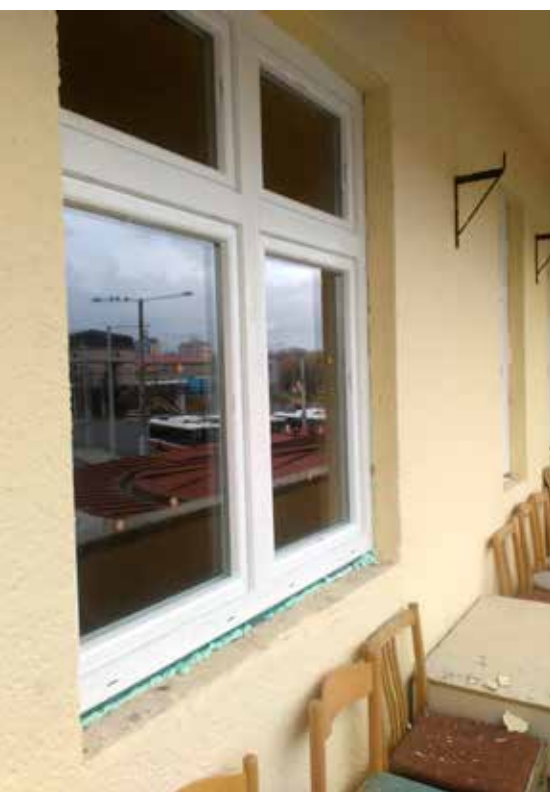
Nové plastové okná dávajú budove krajší, sviežejší vzhľad.
