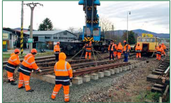
Pôvodné výhybky s drevenými podvalmi v Trenčianskej Turnej nahradili výhybky s koľajnicami UIC, uchytené na betónových podvaloch.
