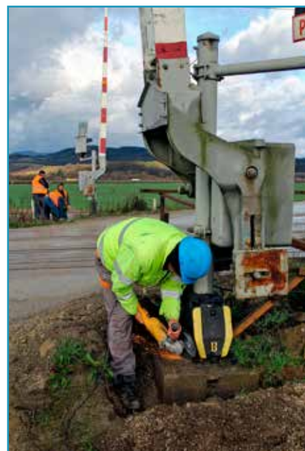
Po ukončení činnosti priecestia zhotoviteľ okamžite demontuje stojany so závorami.
