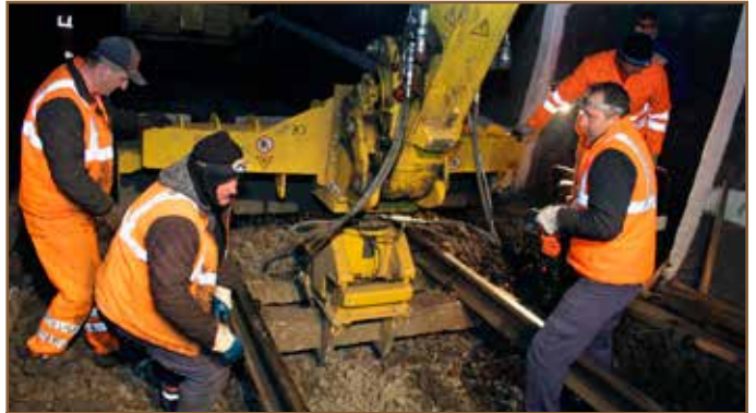
Zamestnanci SMSÚ ŽTS TO Margecany najskôr uvoľňovali poškodené drevené podvaly, aby na ich miesto neskôr upevňovali podvaly betónové.
