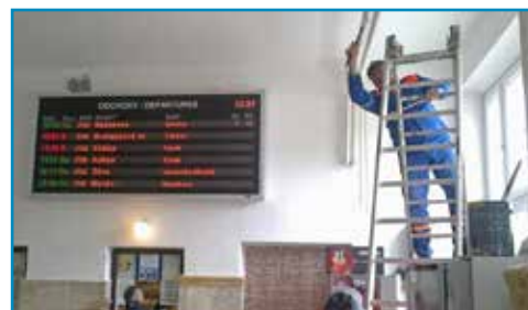
Nové nátery dostali aj rozvodové rúry kúrenia.
