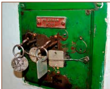
Ústredná zámka v dopravnej kancelárii v Gašparove, ktorá slúži k mechanickej závislosti zabezpečovacieho zariadenia. Pochádza ešte z prvej republiky.
