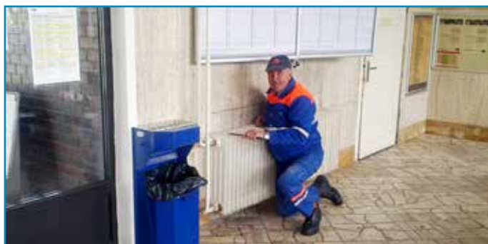
Pred nanosením farby je potrebné dôkladné očistenie.
