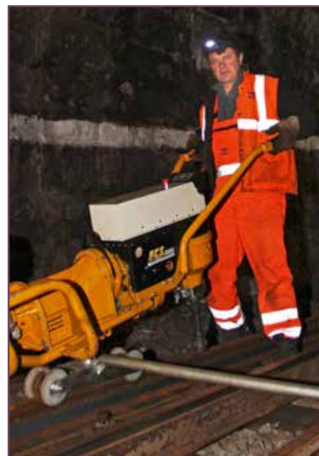
Traťový robotník Ján Dluhoš s motorovou uťahovačkou podvalov.
