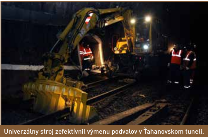
Zamestnanci SMSÚ ŽTS TO Margecany najskôr uvoľňovali poškodené drevené podvaly, aby na ich miesto neskôr upevňovali podvaly betónové.
