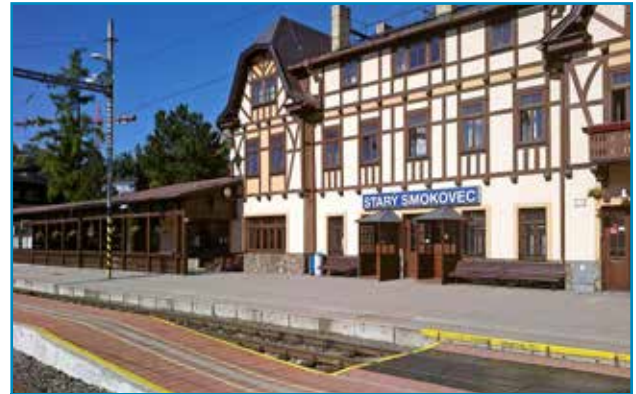
ŽST Starý Smokovec prešla v rokoch 2002 - 2003 komplexnou rekonštrukciou.
