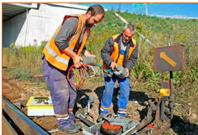
Výmenu 13 prestavníkov realizovali zamestnanci odvetvia OZT iba z materiálu získaného z prestavby modernizovanej trate v obvode OR Žilina.
