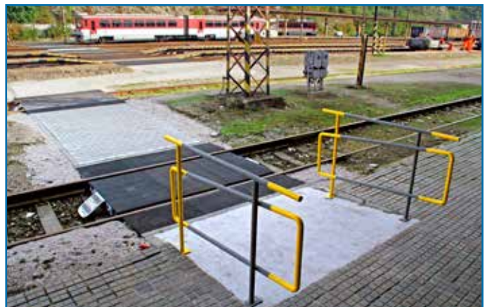
Vo viacerých staniciach, konkrétne aj v Kralovanoch, bol cez koľaje vybudovaný nový železničný priechod zo zámkovej dlažby a pryžovej konštrukcie.
