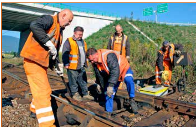
Na akcii sa podieľali aj zamestnanci SMSÚ ŽTS TO Vrútky. Najskôr upravili výhybky na ručné prestavovanie a po montáži prestavníkov opätovne vyregulovali hákové uzávery výhybiek tak, aby dosahovali požadované hodnoty.
