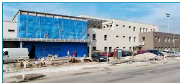
Pred dokončením je druhá časť výpravnej budovy aj s vestibulom.
