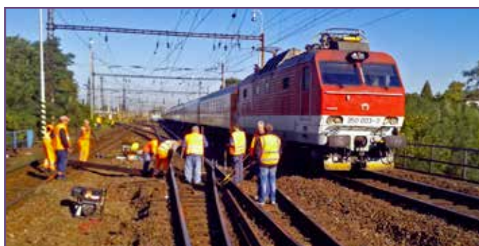
Vkladanie nového podvalu na uvoľnené miesto po poškodenom kuse.
