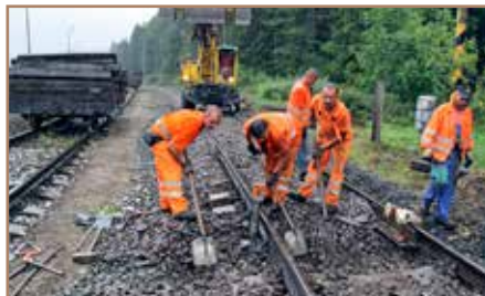
Pri výmene podvalov asistoval zamestnancom SMSÚ ŽTS TO Žilina aj stroj ATLAS1604 z externého prostredia.
