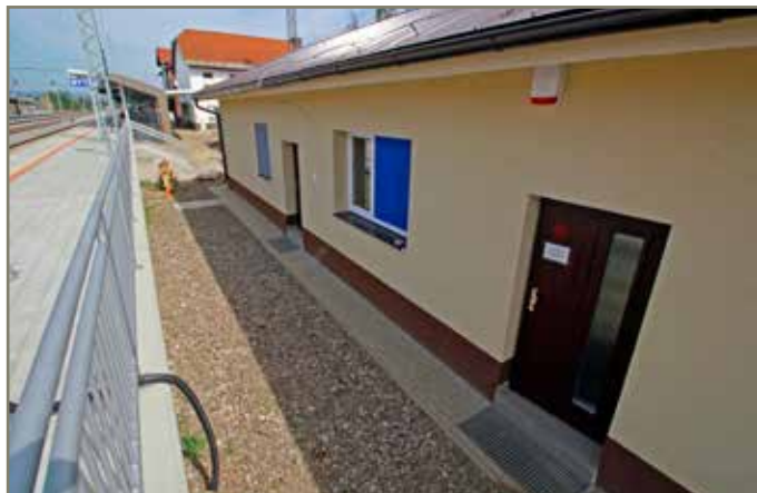
V stanici pribudla ďalšia budova. Za nenápadnými hnedými dverami a modrým plátnom zatieňujúcim okno sa skrýva súčasná dopravná kancelária, ktorá sa sťahovala do týchto priestorov 20. augusta 2015. Z tohto pracoviska je ovládaná aj novovzniknutá výhybňa Plevník - Drienové a automatické hradlo Rašov.
