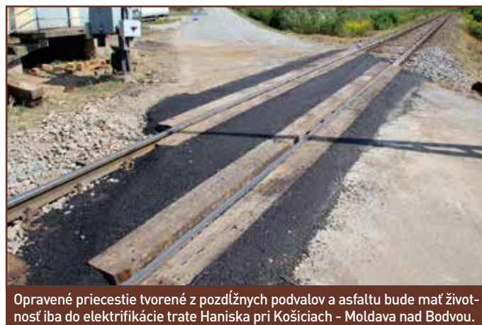
Na 21-metrovom koľajovom poli z priecestia bolo vymenených až 25 podvalov.
