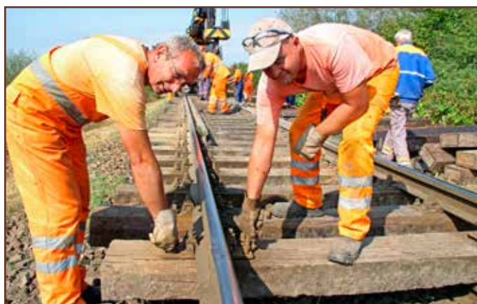
Držebnosť vrtúl v podvaloch na priecestí bola tak slabá, že ich traťoví robotníci Jozef Boka a Imrich Csepely vyťahovali ručne.
