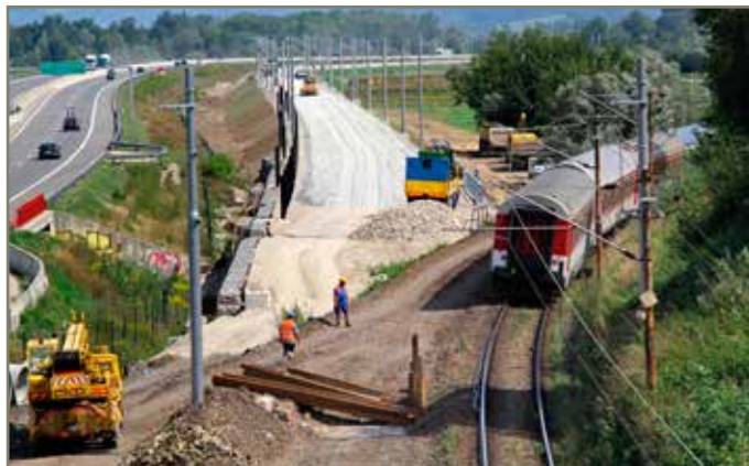
Medzi Bytčou a Dolným Hričivom je modernizovaný 3,5-kilometrový traťový úsek. Vybudujú sa 3 nové železničné mosty a 2 priepusty. Nové trasovanie železničnej trate, ktoré sa snaží kopírovať existujúcu diaľnicu D1 a D3, si vyžiadalo preložku približne 1,5 kilometra existujúcej trasy.
