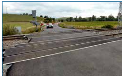
Drevenú výdrevu nahradila konštrukcia STRAIL.
