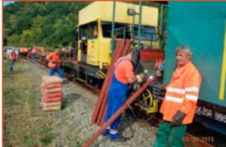
Zamestnanci SMSÚ ŽTS TO Jesenské pripravujú zabezpečovacie značky GPK.
