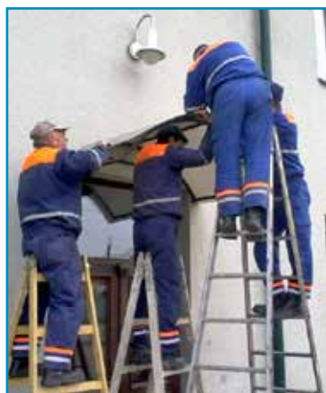
Budovári z Čiernej nad Tisou vymenili lexanové platne na všetkých prístreškoch pri vstupoch do budovy.
