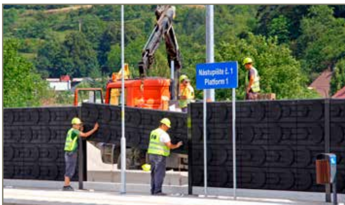
V železničnej stanici Bytča sa dokončuje montáž 2280 metrov dlhej protihlukovej steny. Pre porovnanie – pozdĺž trate od Považskej Teplej po Bytču sa bude tiahnuť 5560 metrov a od Bytče po Dolný Hričov 569 metrov protihlukovej steny.
