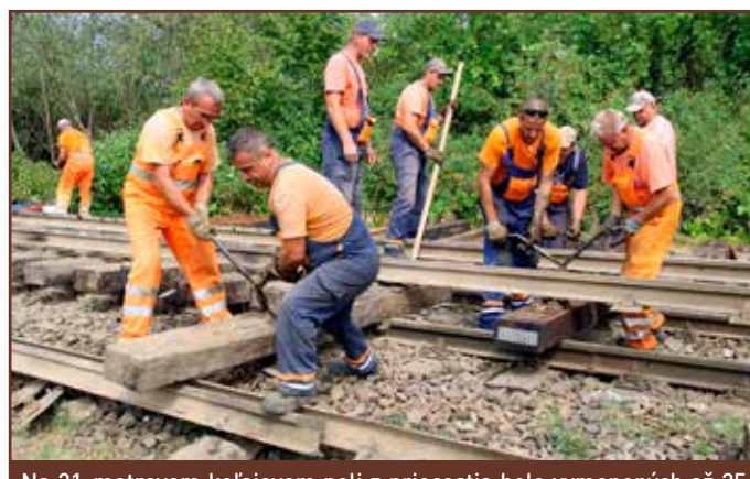
Na 21-metrovom koľajovom poli z priecestia bolo vymenených až 25 podvalov.
