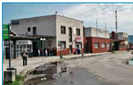
Zámerom revitalizácie predstaničného priestoru je spojenie vlakovej a autobusovej stanice do jedného celku.
