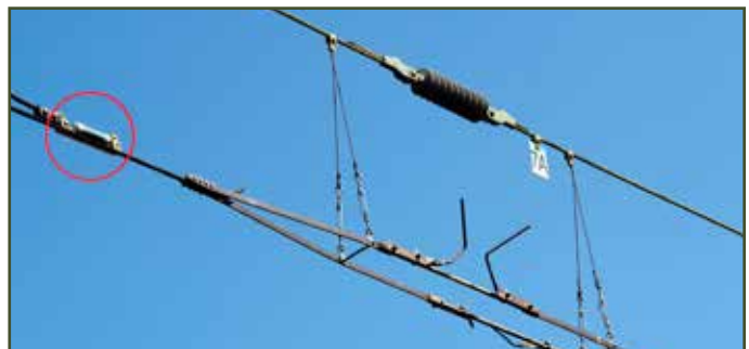
Pred úsekovým deličom je umiestnený indukčný snímač (v červenom krúžku), ktorý je aktivovaný odberom prúdu z troleja.
