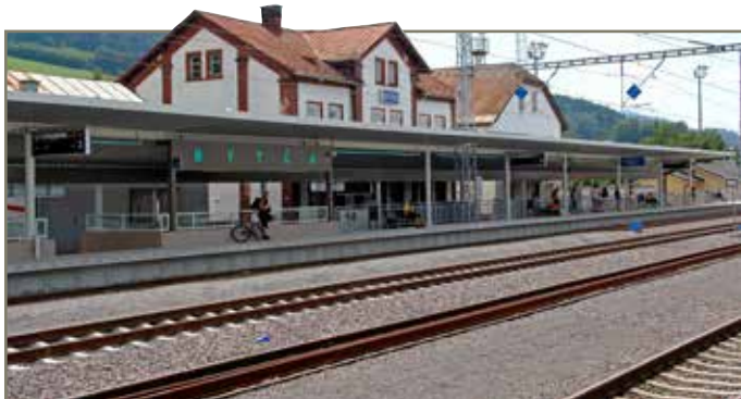
Modernizácia zmenila vzhľad železničnej stanice v Bytči. Namiesto troch jednostranných sypaných nástupíšť vyrástli pri krajných dopravných kolajach 2 nové o dĺžke 250 a 400 metrov. Obe sú zastrešené oceľovou nosnou konštrukciou.
