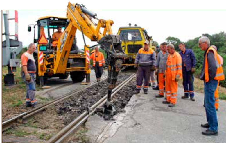
Pri oprave priecestia výdatne pomáhali aj mechanizmy z mechanizačno-dopravného strediska v Spišskej Novej Vsi.
