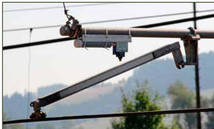
Mechanický zberač na bočnom držiaku trakčnej podpory reaguje na zdvih troleja pod prítlakom nestiahnutého zberača.
