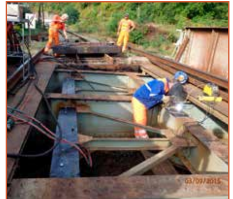
Výmenu mostníc, ale aj ďalšie práce vykonali na moste košíckí mostári.
