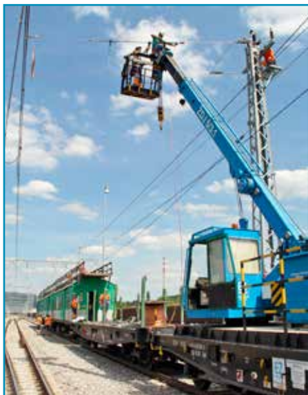
Súčasťou prípravy na zmenu napájania bola aj montáž návěstidiel pre elektrickú prevádzku.
