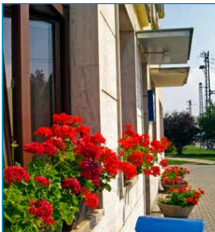
Kvety sú v lete pýchou banskobystrickej železničnej stanice.
