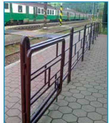
Nové zábradlie najmä kvôli bezpečnosti.
