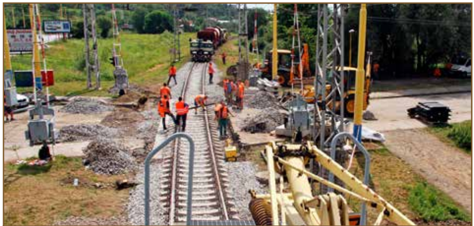
Frekventované železničné priestieanie na Bajkalskej ulici v Prešove v čase komplexnej rekonštrukcie.
