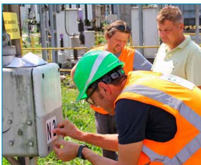
Dušan Čižmár, výrobný dispečer Elektrizace železnic Praha, a. s. dáva nové označenia na existujúce úsekové odpojovače a pohony v TNS Púchov, vyvolané zmenou pomerov v napájaní trakčnej sústavy v ŽST Púchov.
