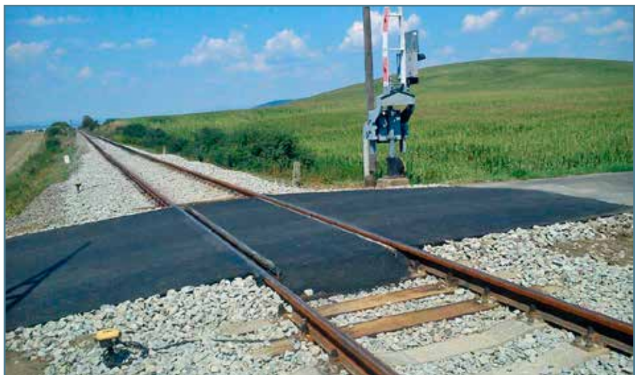
Opravené železničné priecestie na trati Tornaľa – Štrkovec, km 7,766.
