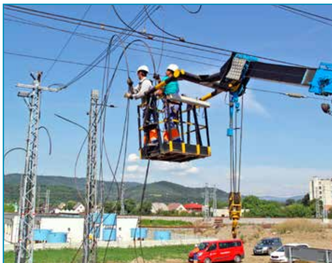
Zmena napájania si vyžiadala aj demontáž pôvodných napájacích vedení.
