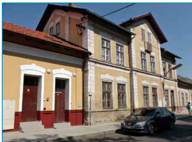
Časť výpravnej budovy je zmodernizovaná, časť ostala v pôvodnom, ošumelom vzhľade. Čaká ju rekonštrukcia.
