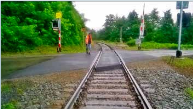
Takto vyzerá priecestie pri zastávke Lovinobaňa po oprave. Rudolf Káčer, ktorý je koordinátorom SMSÚ ŽTS TO Zvolen, skontroloval po asfaltovaní kvalitu prác.
