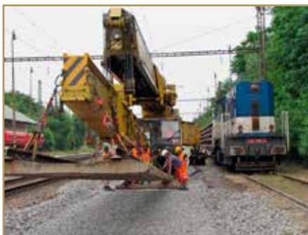
Kým koľaj č. 4 pozostáva z koľajnic tvaru R65, na tretej staničnej koľaji sú už koľajnice typu UIC. Obe sú už na betónových podvaloch. Súčasťou rekonštrukcie bola aj oprava hrán nástupíšť pri koľaji č. 2 a 4.
