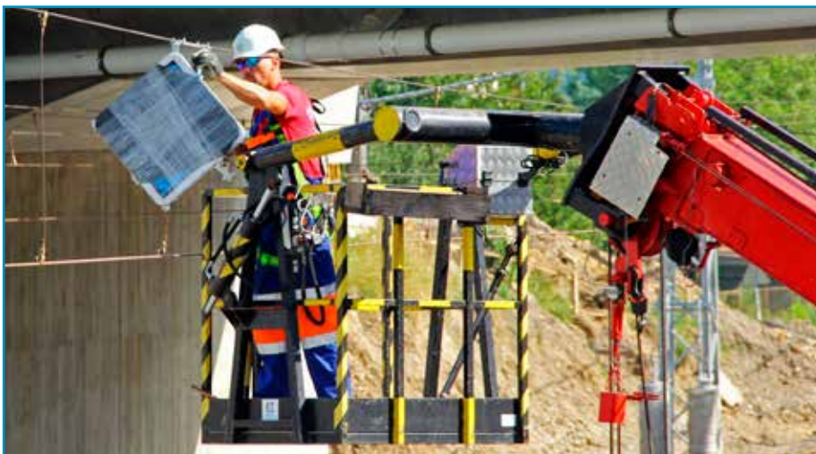
Súčasťou prípravy na zmenu napájania bola aj montáž návěstidiel pre elektrickú prevádzku.
