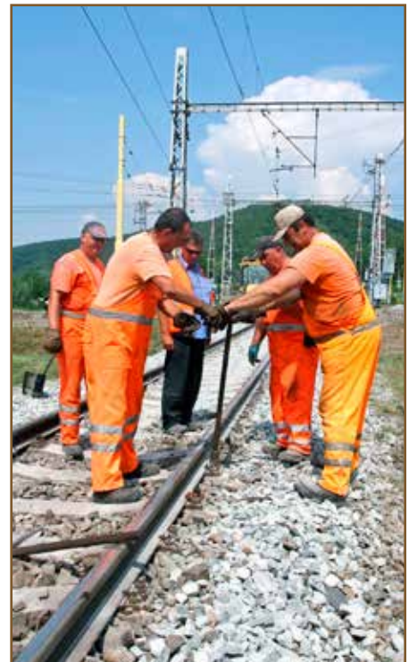
Počas vyluky prvý deň poriadne zmokli a druhý sa už riadne zapotili traťoví robotníci Peter Maďar a Štefan Patrik, ktorí dohávajú upevňovadlá kľúčom. Rovnako ako aj Ján Smrek (vľavo) a Vladimír Maček, zámočník koľajových konštrukcií (vpravo), ktorí sa vyluky zúčastnili počas troch dní. Vzadu, v strede Jozef Jančuš.
