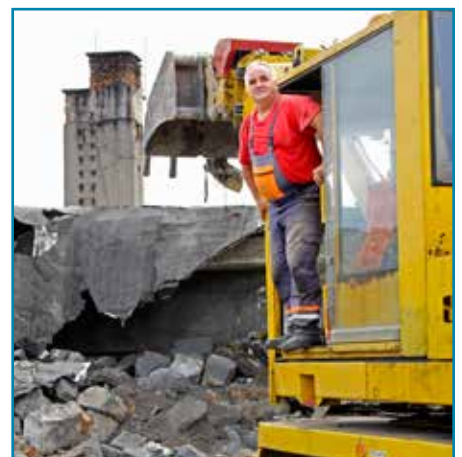
Stavebný strojník Ján Nalevanko z M0 Košice mal počas búrania zo svojej UDS-ky nevábný pohľad.
