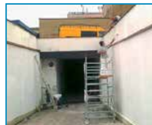
Šikovná partia prešovských budovárov si prednedávnom poradila s opravou odchodového tunela.
