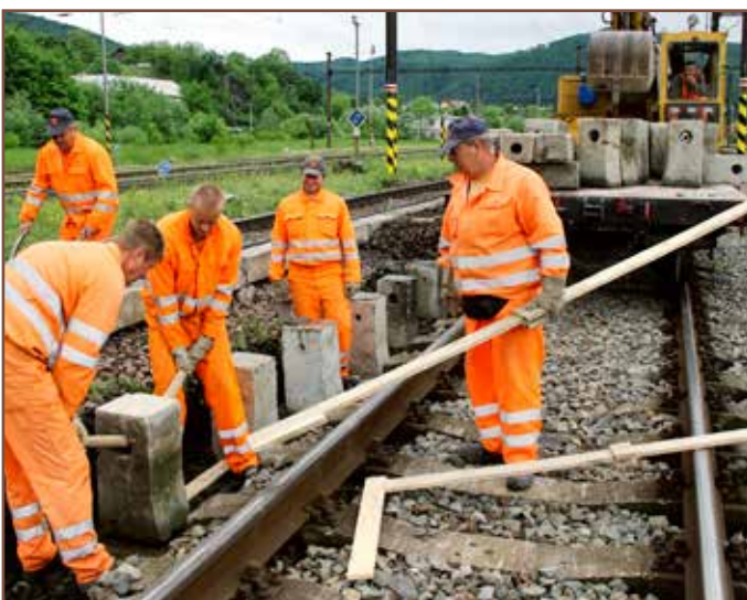
Zamestnanci SMSÚ ŽTS Tu0 Margecany predĺžili perón pri 2. staničnej koľaji z vyzískaného materiálu.
