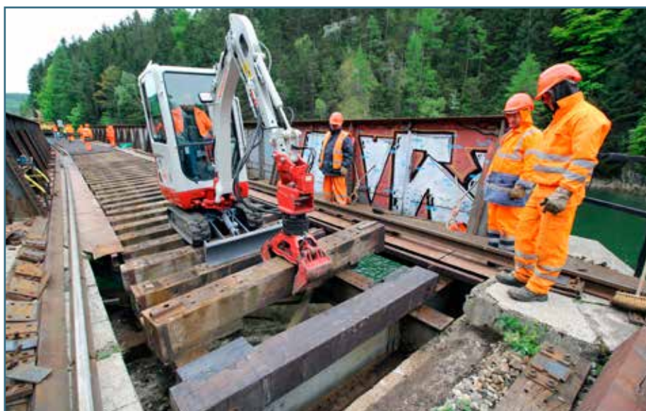
Na moste pri Dedinkách mostári vymenili 87 mostníc a 2 pomúrnice. Pri manipulácii s nimi im pomáhal aj stroj.
