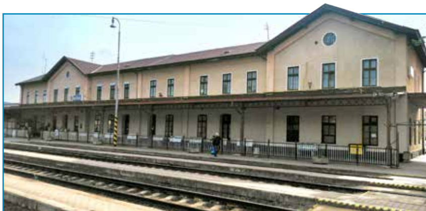
Železničná stanica Nitra sa, žiaľ, projektov, ktoré boli na jej rekonštrukciu pripravené, nedočkala.
