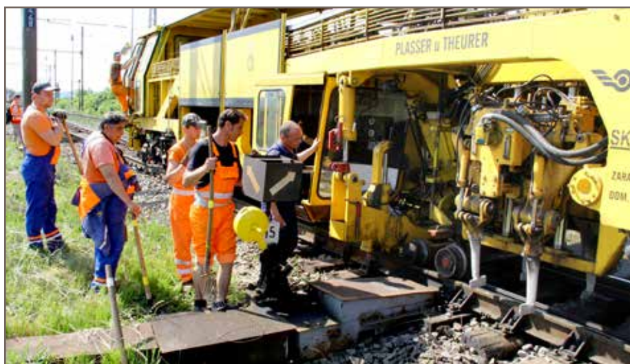
Podbitie výhybky si vyžaduje aj veľkú dávku opatrnosti, aby nedošlo k poškodeniu prestavovacieho mechanizmu výhybky.
