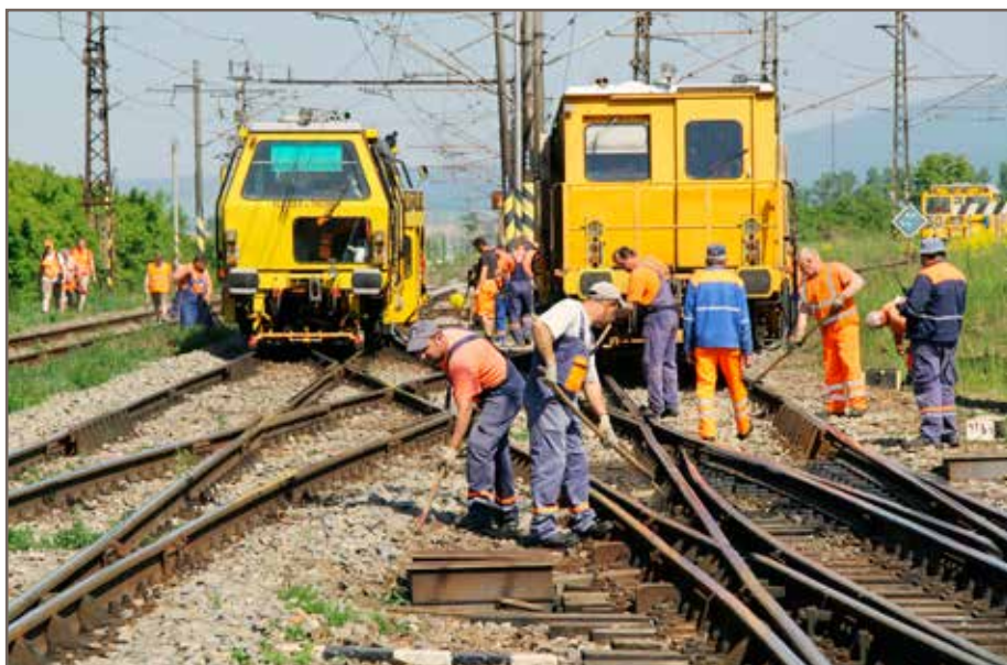
Koľaje a výhybky dvojitej koľajovej spojky v Michalánoch podbíjali naraz dve podbijačky z SMSÚ ŽTS MDS Spišská Nová Ves.
