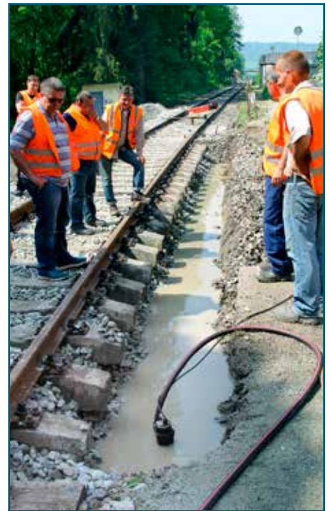
Vedúci SMSÚ ŽTS TO Žilina Michal Obložinský (vľavo) riešil nečakaný problém – vodu vo vykopanej jame. Pomohlo čerpadlo.
