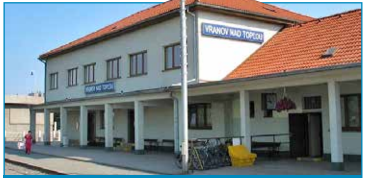
Železničná stanica Vranov nad Topľou spĺňa všetky podmienky štandardizovanej stanice už dnes.
