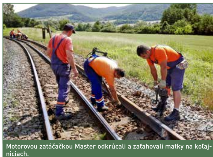
Vymieňanie koľajníc realizovali zvolenský traťováci pomocou podvozku Mamatej.
