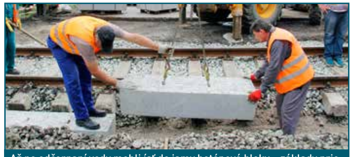
Až po odčerpaní vody mohli ísť do jamy betónové bloky – základy priecestnej konštrukcie STRAIL.
