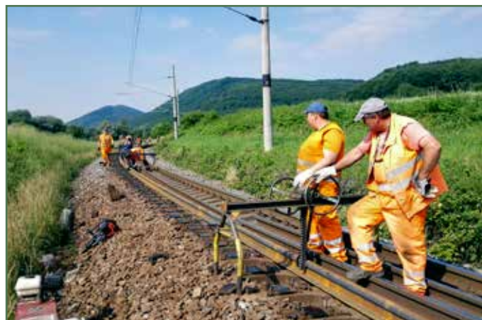
Vymieňanie koľajníc realizovali zvolenský traťováci pomocou podvozku Mamatej.
