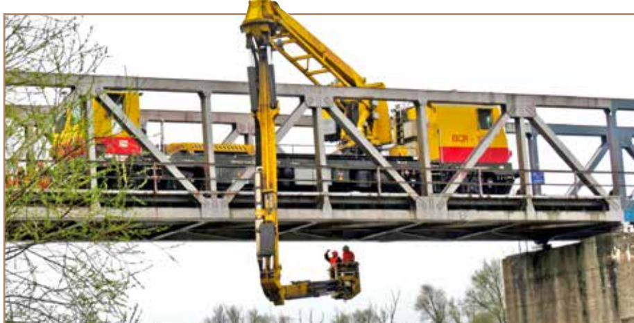
Zložitý mechanizmus rakúskeho stroja umožňuje detailnú revíziu jednotlivých konštrukčných prvkov mostnej konštrukcie, či už zospodu, alebo zhora.
