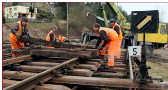
Zamestnanci SMSÚ ŽTS TO Žilina demontovali v Lietavskej Lúčke 2 výhybky uchytené na ocelových podvaloch.
