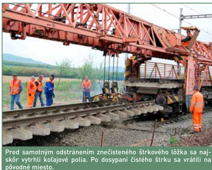
Štrkové lôžko znečistené blatom nahradilo čisté. Pri tejto akcii asistovali stroje z SMSÚ ŽTS MDS Trebišov a Spišská Nová Ves.
