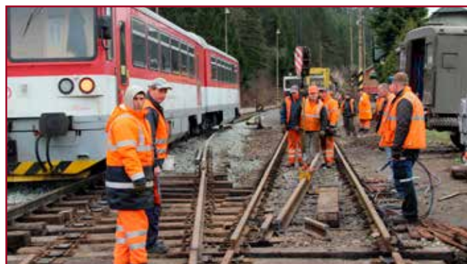
Výhybky sa menili za plnej prevádzky. Traťováci museli byť obozretní - kým pracovali v jednej koľaji, za chrbtom im jazdili vlaky.
