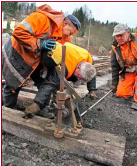
Montáž a nastavenie výmenového závažia si vyžaduje nielen silu mocných chlapcov, ale aj dostatok kumštu a dôvtipu.
