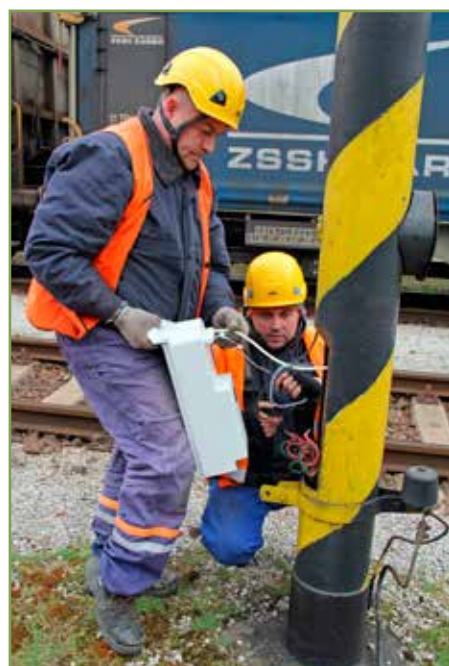
Benjamín Kováč a Jozef Král pri montáži skrinky dbajú na presné zapojenie vodičov, aby nedošlo ku skratu.
