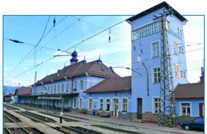
Nezameniteľnou dominantou ružomerskej stanice je vodárenská veža.
