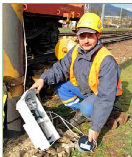
Elektromontér Pavel Gaľa ukazuje plastovú skrinku s istiacimi a ochrannými prvkami, ktorá je už pre zlodějov kovov neatraktívna. Nedostupný je pre nich aj oddelovací transformátor.
