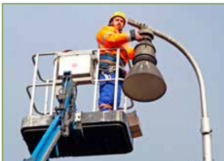
Elektromontéri vymenili v Margecanoch všetkých 50 starých svietidiel s 250 wattovými výbojkami.
