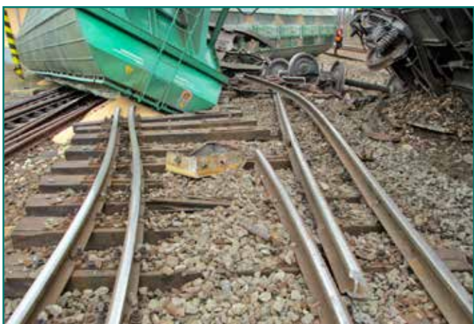
Následkom tejto nehody došlo aj k značnému poškodeniu železničnej infraštruktúry.
