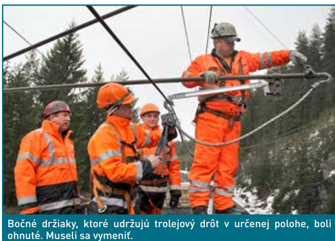
Elektromontéri Roman Duriš (v popredí), Tomáš Ilavský a vpravo majster OTV Štrba Ján Ilavský. vymieňajú pokrivené rameno trakčnej podpory.
