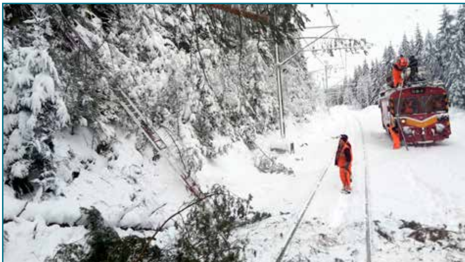
Koncom januára odstraňovali elektromontéri z SMSÚ EE TV Liptovský Mikuláš takmer 40 stromov zachytených v trakčnom vedení.
