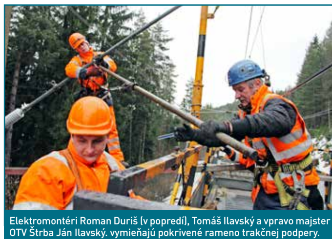
Bočné držiaky, ktoré udržiavajú trolejový drôt v určenej polohe, boli ohnuté. Museli sa vymeniť.
