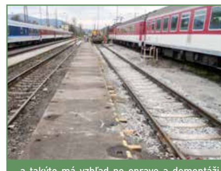
...a takýto má vzhľad po oprave a demontáži výhybiek.
