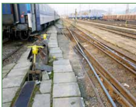
Takto vyzeralo piate nástupište pred opravou...
