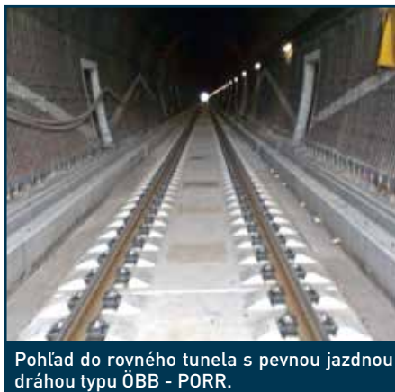
Podklad pre pevnú jazdnú dráhu bol vyhotovený z prostého betónu, ktorým bola obetónovaná aj nová stredová odvodňovacia stoka.
