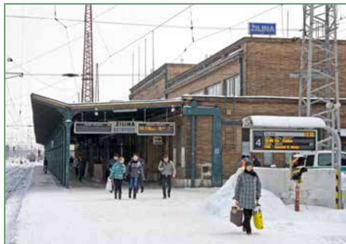
Stanica v Žiline čaká na rekonštrukciu. Dovtedy sa urobia aspoň drobné opravy fasády a úpravy plôch.
