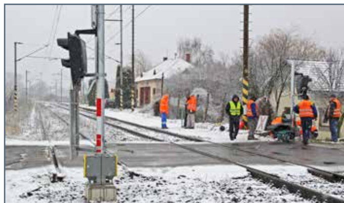
Aj umiestnenie priecestného výstražníka v 2. dopravnej koľaji naznačuje koniec výhybne. Koľaj, výhybky a trolej budú časom zdemontované.
