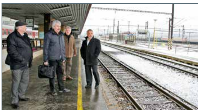
Zadanie na rekonštrukciu nástupíšť 1, 2, 3 je potrebné ešte doplniť a dopracovať. Investície pôjdu na košickú stanicu nielen kvôli odstráneniu havarijných stavov, ale aj do nových výhybiek, traťostanice, osvetlenia, ako aj do úprav priestoru vonkajšieho výpravcu.
