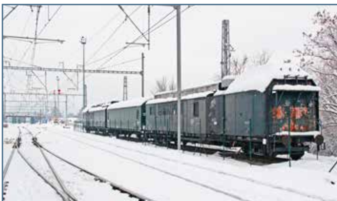
Za žilinským zhlavím ŽST Púchov bude prechod medzi striedavou a jednosmernou trakciou. Pripravená je tu aj prevozná trakčná meniareň, ktorá bude napájať jednosmerným napätím úsek smerom k Považskej Bystrici.
