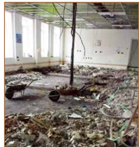
Začiatok výstavby kompletne nového datacentra na Trnavskej ulici.
