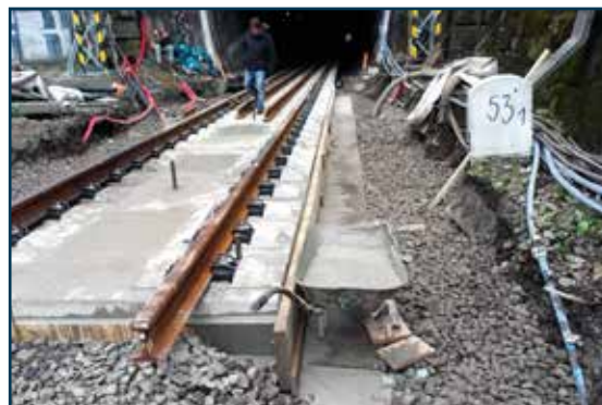
Na rozdiel od tunela pod Tureckým vrchom, kde je pevná jazdná dráha z liateho betónu, boli v Bratislavskom tuneli použité prefabrikované dosky.
