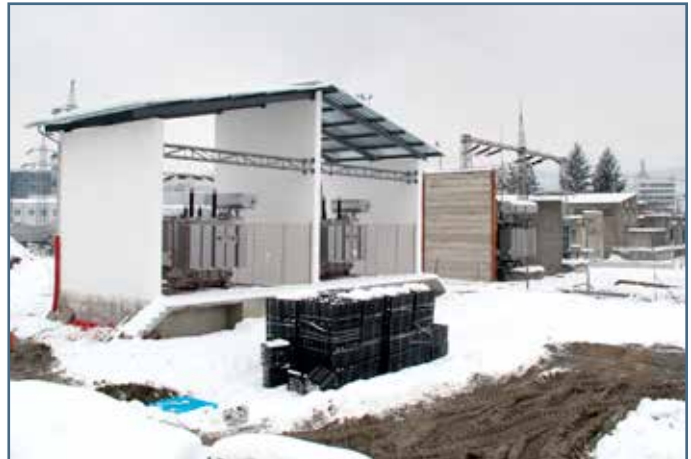
Nová 110 kV rozvodňa nie je ešte pripojená k verejnej energetickej sieti. Po oživení nahradí doterajšiu 110 kV prípojku z rozvodne Matoru, od ktorej bola závislá existujúca trakčná meniareň.
