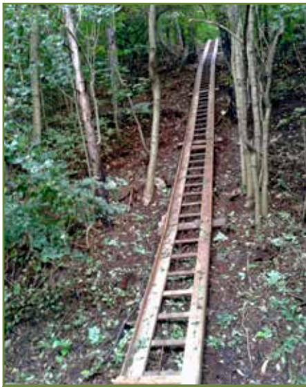
Stavebný vrátok. Ten poslužil ako výťah na nanosenie materiálu do kopca.
