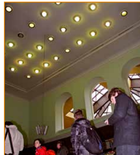
Vstupnú halu starej časti bratislavskej hlavnej stanice, cez ktorú denne prejdú tisíce cestujúcich, nonstop osvetľuje 36 svietidiel.
