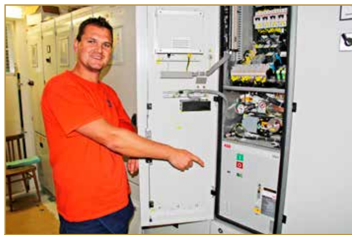
Elektromontér Pavol Bodnár z SMSÚ EE NaSpS Košice ukazuje v distribučnom kontajneri na nový vákuový vypínač 22 kV rozvodne.
