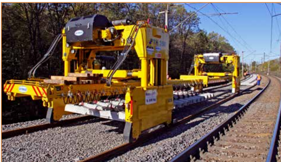
Betónové podvaly rozmiestňoval pokladač podvalov PTH 350 Donelli.
