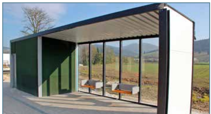
Zastávky Predmier a Plevník - Drieňové nadväzujú na protihlukovú stenu, ktorá je z absorpčných gumových panelov. Tie sú použité aj na stenách prístreškov, takže majú absorpčnú a zároveň aj dizajnovú funkciu. Malý priestor v prístrešku bude slúžiť pre zabezpečovacie zariadenie.
