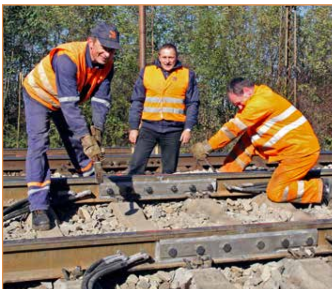
V strede Martin Ružička, vedúci prevádzky SMSÚ OZT ZT Slanec sleduje návštevých majstrov Mariána Pusztaya a Petra Novotného (vpravo) pri montáži lán od stykových transformátorov pre činnosť koľajových obvodov sústredného autobloku.
