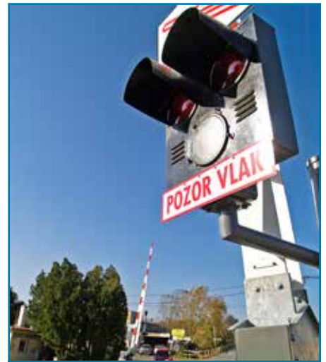
Mechanické priecestné zabezpečovacie zariadenie vystriedalo nové, so závorami a svetelnou signalizáciou.
