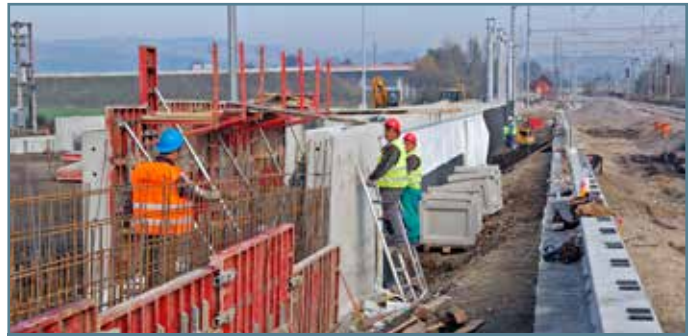
Časť nástupištia pri 4. koľaji bude v predčasnej prevádzke od 28. novembra 2014. Ukončenie výstavby podchodu pre cestujúcich v ŽST Bytča je naplánované na polovicu augusta 2015.
