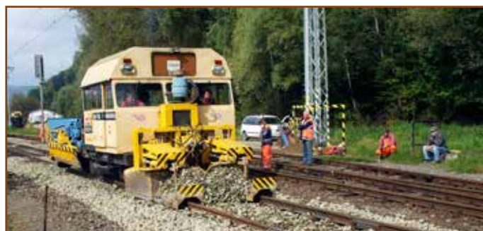
Zrušené boli tri výhybky, ktoré smerovali na dnes už neexistujúcu vlečku.
