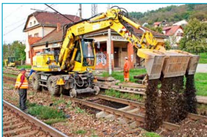
Na odťaženie štrku spod koľajnic slúžila špeciálne upravená lyžica.
