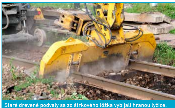
Dvojcestné vozidlo LIEBHERR 900 LITRONIC odbremenilo traťových robotníkov od manipulácie s ťažkými betónovými podvalmi.
