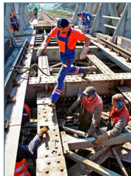
Rýchlo, rýchlo... Od vyhne sa náhli Štefan Okel s rozhorúčeným nitom, ktorý musí čo najskôr skončiť v otvore oceľovej konštrukcie.
