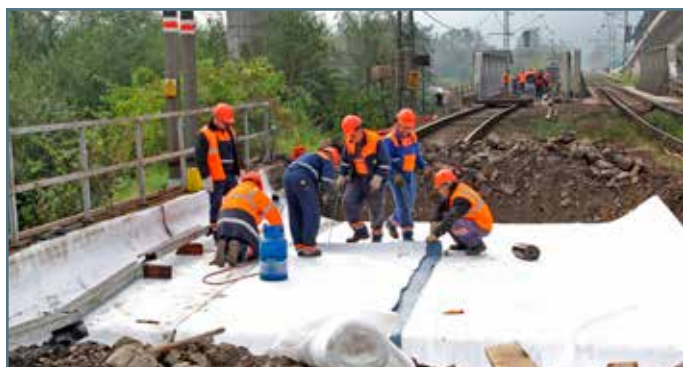
Chlapi z bratislavského mostného obvodu ukázali v Čadci široké spektrum svojej pracovnej činnosti. Na betónovom moste položili hydroizoláciu a o sto metrov ďalej zároveň opravovali oceľový most.
