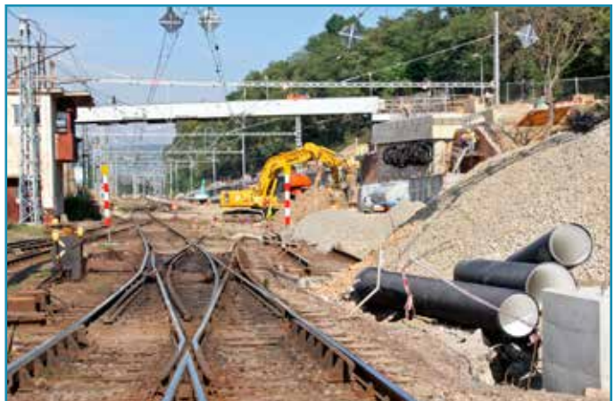
Od 14. novembra budú pre tranzitnú dopravu použiteľné len koľaje č. 7 a 3 – najbližšie k staničnej budove. Hlavné staničné koľaje č. 1 a 2 budú nezjazdne pod budovaným nadjazdom na žilinskom zhlaví až do jeho dokončenia v júni 2015. Vlaky v smere na Horní Lideč budú môcť jazdiť len po koľaji č. 3. Výluky 2. trafovej koľaje do Považskej Bystrice a staničných koľaji č. 6 - 18 potrvajú do 12. decembra 2014.
