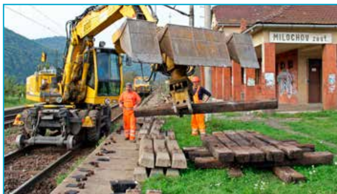
Univerzálny stroj s ľahkosťou vyberal drevené podvaly a ukladal ich na kopy.
