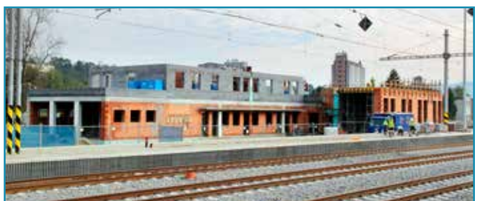
Rastie aj nová budova trafového obvodu. Pôvodná musela ustúpiť modernizovanému koľajisku, preto bola zbúraná.
