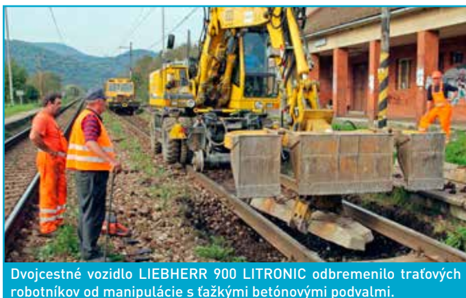
Traťoví robotníci vykonávali obslužnú činnosť – demontovali a späť montovali upevňovadlá a pružné podložky.
