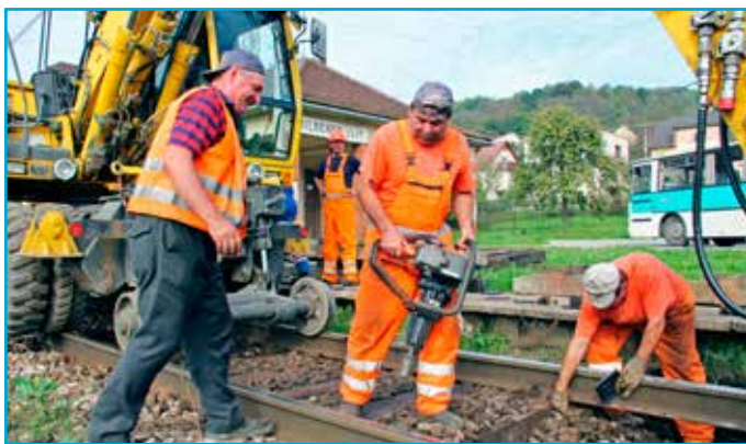
Traťoví robotníci vykonávali obslužnú činnosť – demontovali a späť montovali upevňovadlá a pružné podložky.
