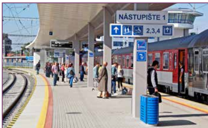
Rekonštrukcia prvého nástupištia a príslušných koľají začala 15. júna, v predčasnom užívaní je od 23. septembra. Zrealizovala sa kompletne, vrátane informačných tabulí, kamerového systému, ale aj odpadkových košov. Pribudlo zasklenie schodišťa aj fontánka.
