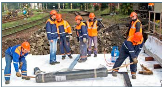
Stará izolácia betónového mosta bola nefunkčná, most zatekal a taktiež omietka padala na cestu pod mostom. Mostári už nemohli ďalej čakať, preto položili novú hydroizoláciu a vyriešili aj odvodnenie.
