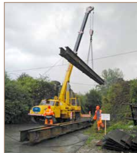
Mostári najskôr rozobrali pôvodnú konštrukciu mosta, ktorú tvorilo dlhodobo zabudované mostné provizórium.
