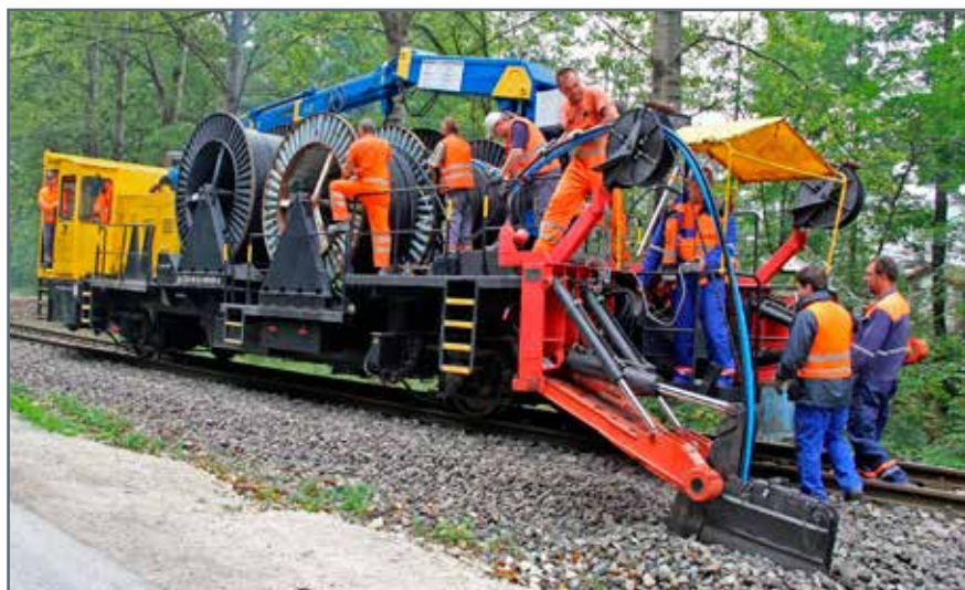
Kábelový pokladač uľahčil kábelárom namáhavú prácu. Poloautomaticky ukladá káble do hĺbky 80 cm od nivelety koľaje.
