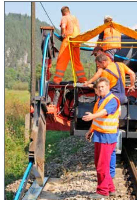
Stroj prechádza cez priepust so zdvihnutým rýpadlom. Celú akciu riadi Ing. Ján Dvorský, vedúci SMSÚ OZT KT Zvolen (v popredí).
