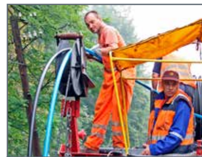
Káble nahradia dosluhujúce nadzemné vedenie na stožiaroch.
