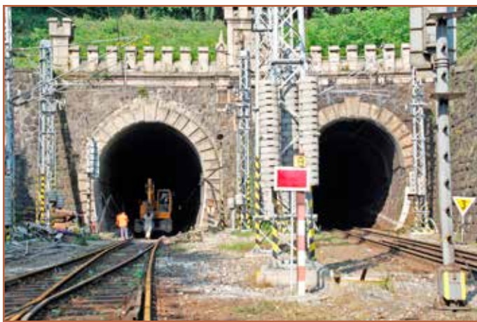
Rekonštrukcia ľavého tzv. Rovného tunela sa deje počas opravy koľaje na Červenom moste.
