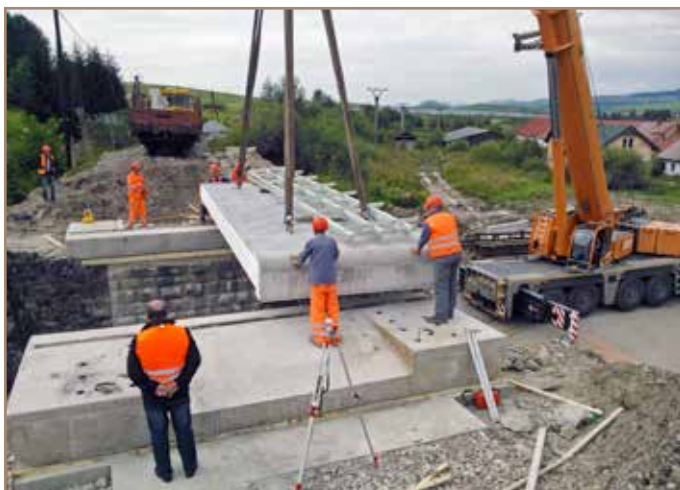
Ukladanie strednej a zároveň najťažšej, 50-tonovej dosky železobetónovej nosnej konštrukcie.
