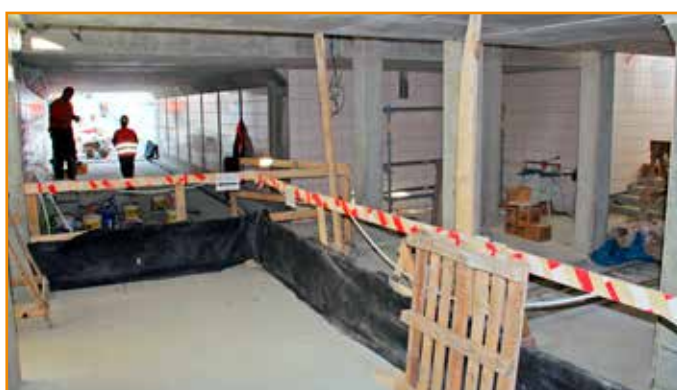
Podchod sa používa v obmedzenom režime, prístupný je iba po 3. nástupište. Pre pohyb cestujúcich je vymedzená len jeho ľavá časť s východmi na nástupištia, na pravej pracujú stavbári. Sprístupnený nie je ani východ na Hodžovu ulicu.
