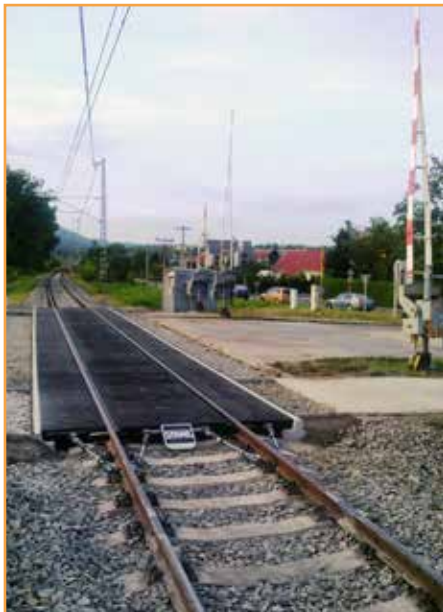
Starú gumokovovú konštrukciu nahradila nová celopryžmová STRAIL.
