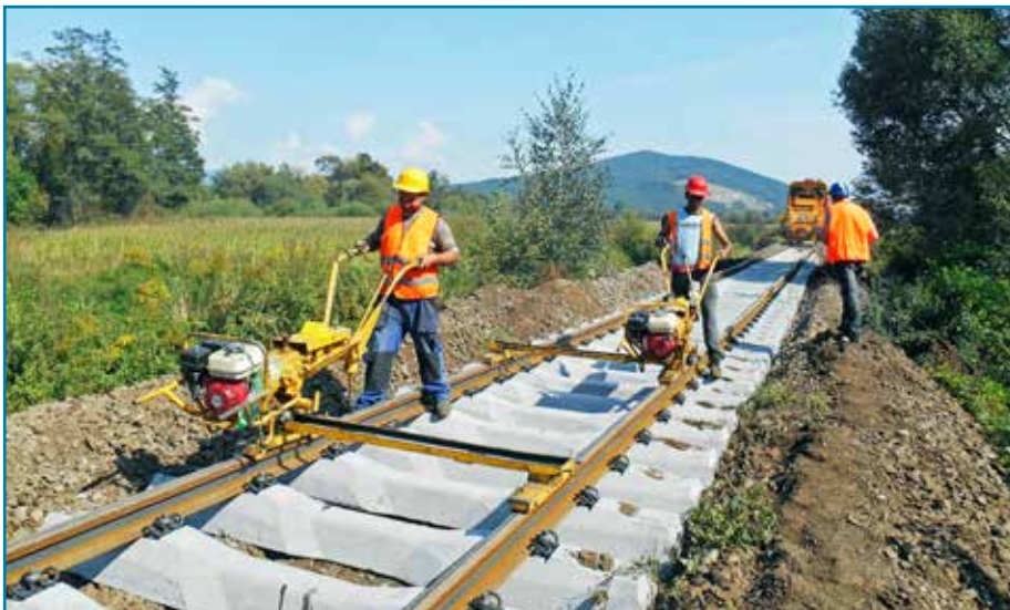
Nové betónové podvaly BP-3/S s pružným upevnením SKL21.
