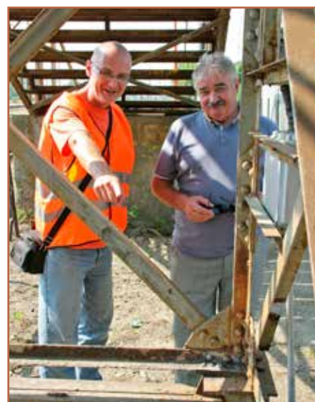
Miroslav Valach (vľavo), majster SMÚ MO Zvolen ukazuje Pavlovi Pokrývkovi nosníky lávky oslabené koróziou.
