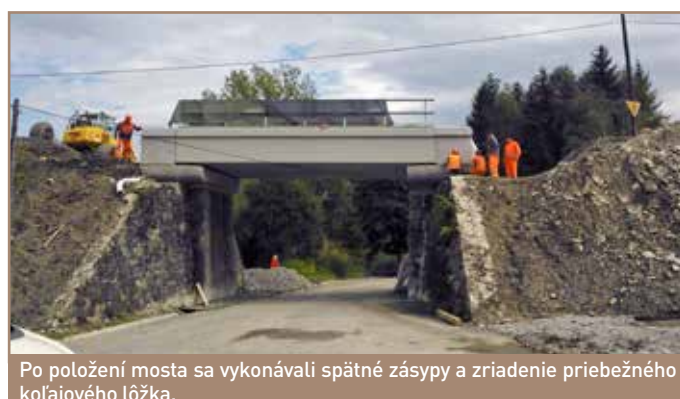
Mostári upevnili zábradlie do pripravených otvorov v krajných doskách.
