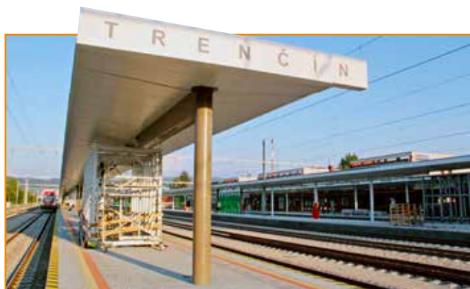
Na nástupištiach sa dokončujú práce na osvetlení, podhladoch, osadzujú sa lavičky a odpadové koše. Naďalej je vo výstavbe batožinový podchod.
