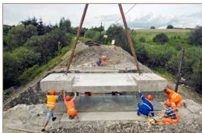
Na upravené opory sa umiestňovali prefabrikované úložné prahy.
