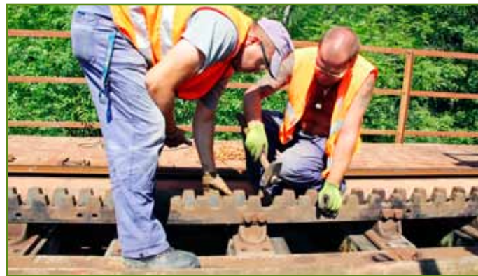
Na Tisoveckej zubačke, na rozdiel od zubačky vo Vysokých Tatrách, je použitý Abtov systém s dvoma ozubnicovými pásmi.
