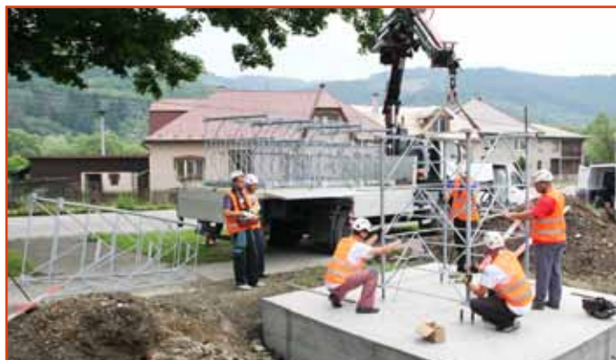
Ludia z firmy Lukromtel, s.r.o. stavali stožiare z dvojmetrových dielov.
