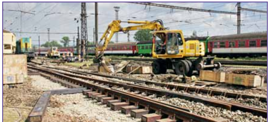
Rekonštrukcia 21 výhybiek na niekoľko mesiacov obmedzovala železničnú prevádzku.
