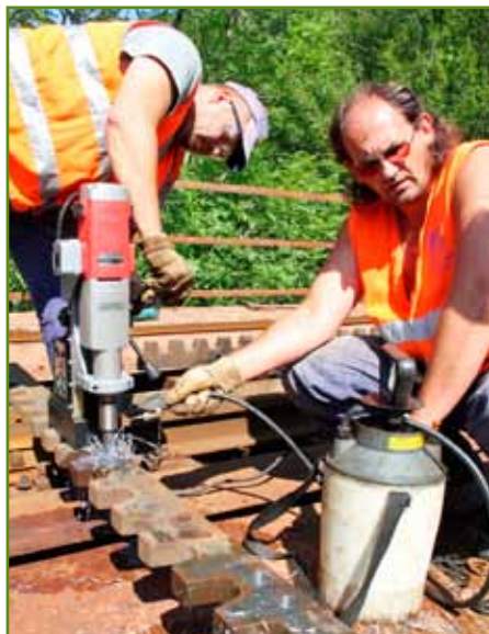
Do dielov ozubnice sa museli vŕtať nové otvory, aby sa mohli upevniť k mostniciam. Ich vzdialenosť na Čertovom viadukte už je iná ako bola kedysi.
