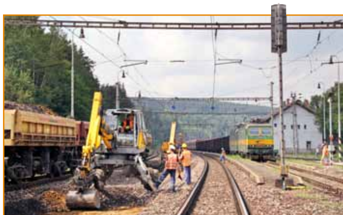
Železničné stavby, a. s. komplexne zrekonštruujú železničný zvršok 1. a 2. koľaje, opravujú aj koľajové lôžko pod 3. a 4. koľajou. Na zhlaviach stanice dôjde k úprave geometrickej polohy 16 výhybiek.
