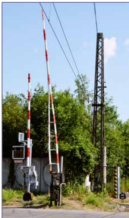
Nové výstražníky sú umiestnené pred jestvujúcimi mechanickými závorami. Pred výstražníkom je na vozovke vyznačená biela „STOP“ čiara.
