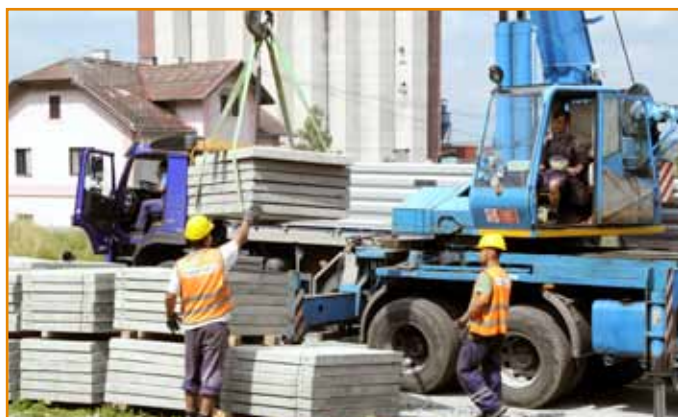
Skladanie prefabrikovaných dosiek pre tri nové 200-metrové nástupištia. Budú o 100 metrov kratšie ako pôvodné peróny sypané štrkom.
