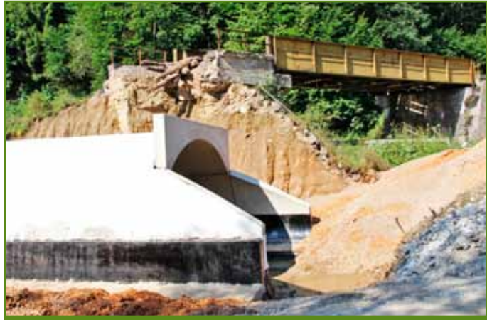
Cestu pod železničným mostom rozšíria a potok Furmanec potečie v preloženom koryte pod novým mostom. Jeho výstavba prerušila trať ozubnicovej železnice.
