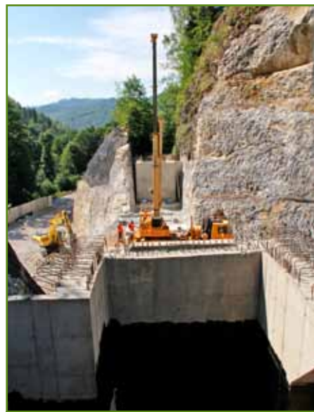
Cestu, ktorá v súčasnosti vedie pod Čertovým viaduktom, preložia do zárezu skalného brala, z ktorého odstrelili tony kamenia. Trať preklenie nový železničný most.
