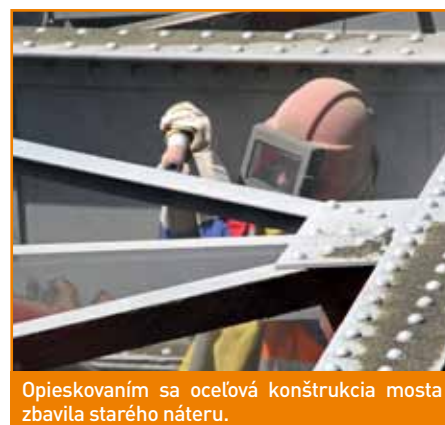
Mnohé prvky nosnej konštrukcie napadla korózia. Museli sa meniť.
