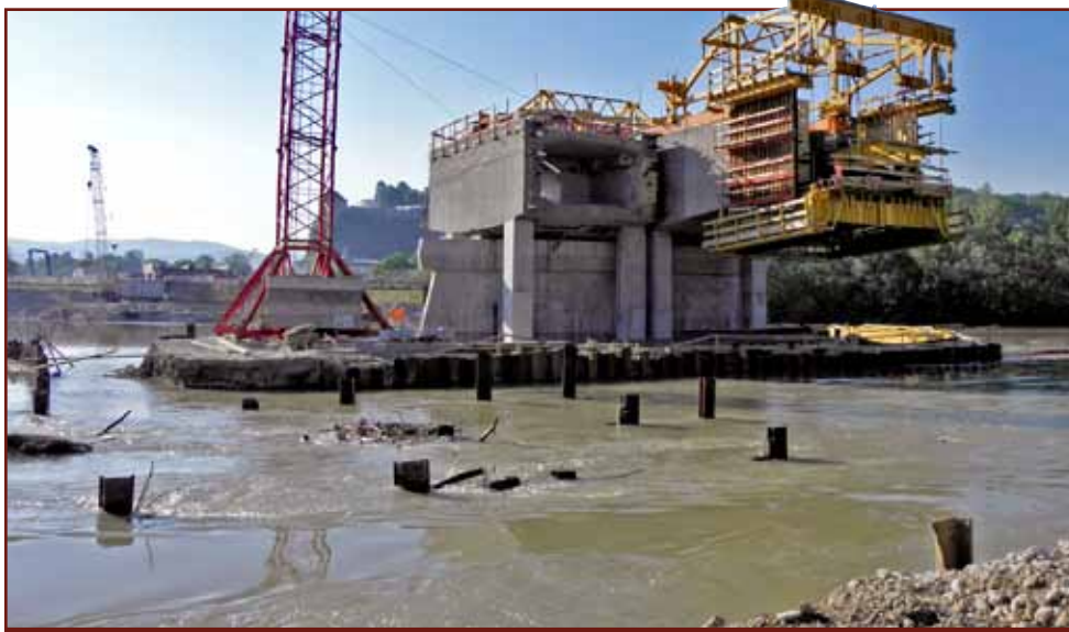
Vysoká voda odplavila provizórnu prístupovú cestu k pilieru č. 5.
