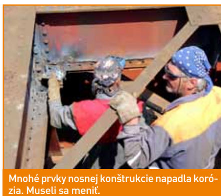
Pôvodné spodné uholníky nahradili masívnejšie, aby oceleová konštrukcia vyhovovala väčšiemu zaťaženiu.
