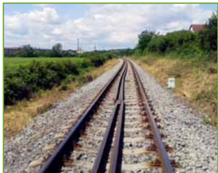
Koľajnice typu 'India' v strede koľajiska po výmene za nové S 49.
