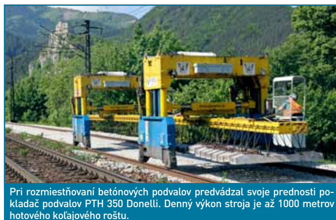
Na naukladané betónové podvaly sa ihneď upevňujú 75-metrové koľajnicové pásy. Zariadenie na nasadzovanie koľajnic obsluhuje iba jeden človek.
