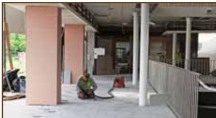
Stavebné práce sú v plnom prúde a už o niekoľko týždňov začne II. etapa revitalizácie, v ktorej sa vybuduje nová prístavba na priechelí staničnej budovy a slúžiť bude ako terasa s kaviarňou.
