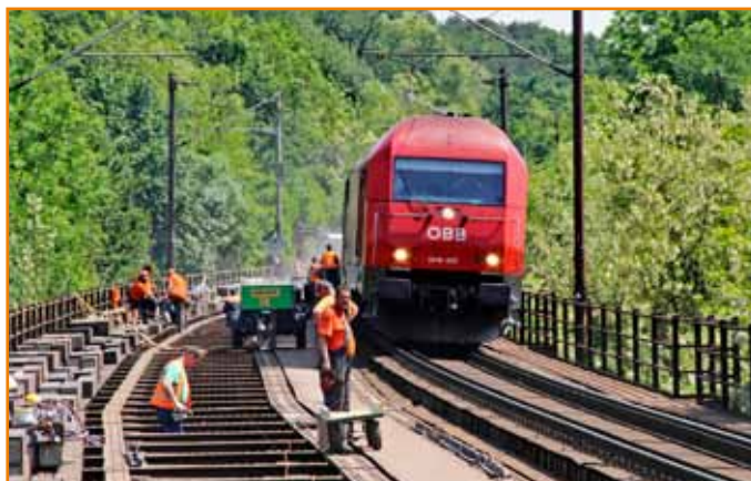
Na Červenom moste medzi bratislavskou hlavnou stanicou a Lamačom je mimoriadne frekventovaná doprava. Počas výlukových prác jazdia všetky vlaky v oboch smeroch po susednej koľaji.
