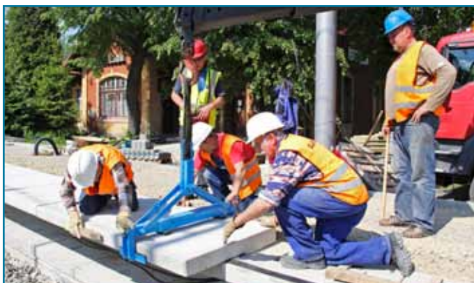
Súčasne s 1. traťovou koľajou sa rekonštruje aj nástupište na zastávke v Strečne.
