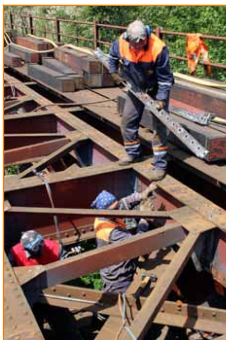
Pôvodné spodné uholníky nahradili masívnejšie, aby oceleová konštrukcia vyhovovala väčšiemu zaťaženiu.
