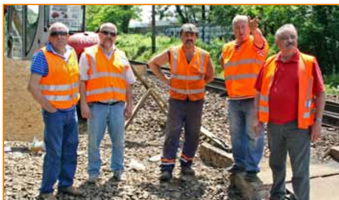
Zľava Dušan Malík - vedúci strediska MO Bratislava, Ing. Ján Uhnavý - riaditeľ OR Trnava, Dušan Fraňo - majster MO Bratislava, František Horváth - stavbyvedúci Železničné Stavebníctvo a. s., Bratislava a prednosta sekcie ŽTS OR Trnava Bc. Pavol Pokrývka diskutujú o rozsahu opravných prác.
