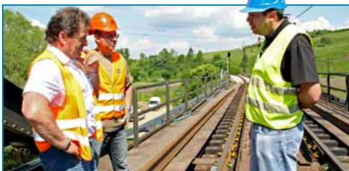
Napravo Ing. Jaroslav Svoboda, stavbyvedúci firmy GJW Praha s. r. o. opisuje problémové miesta rekonštrukcie. Pozorne ho počúvajú (zľava) Ing. Jozef Blahovec, prednosta sekcie ŽTS OR Žilina a Ing. Petr Kliment, vedúci prevádzky SMSU ŽTS TO Žilina.
