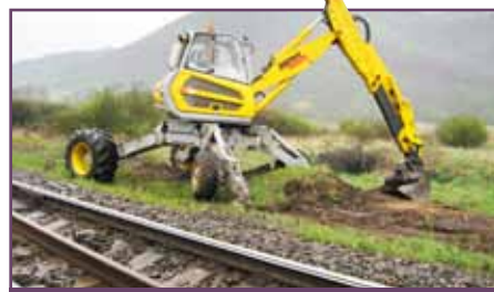
Menzimuck v akcii pri úprave svahu pri prácach na výluke trati Hronská Dúbrava – Žiar nad Hronom.
