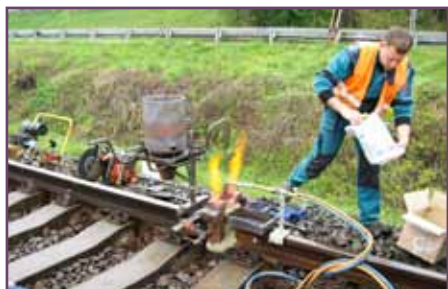
Zriadenie bezstykovej koľaje. Zriadenie montážnych a záverných zvarov termitom.
