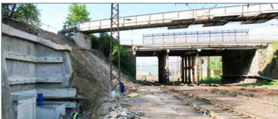
Cestný nadjazd nad žilinským zhlavím v ŽST Púchov sa musí prebudovať, keďže kolajisko pod ním zmení konfiguráciu. Prekladajú sa aj inžinierske siete.
