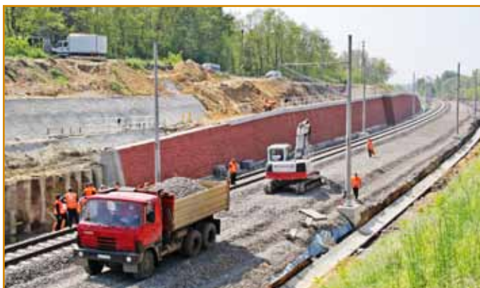
Pôvodne jedna oporná konštrukcia múru dlhá 380 metrov bola rozdelená na 4 rôzne typy.
