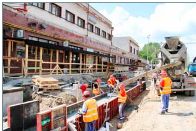
Pracuje sa aj pod oknami staničnej budovy na základoch prvého nástupišťa.
