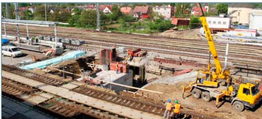
V strede kolajiska stavbári budujú ostrovné nástupište č. 2, doprava je vedená po krajných kolajach.
