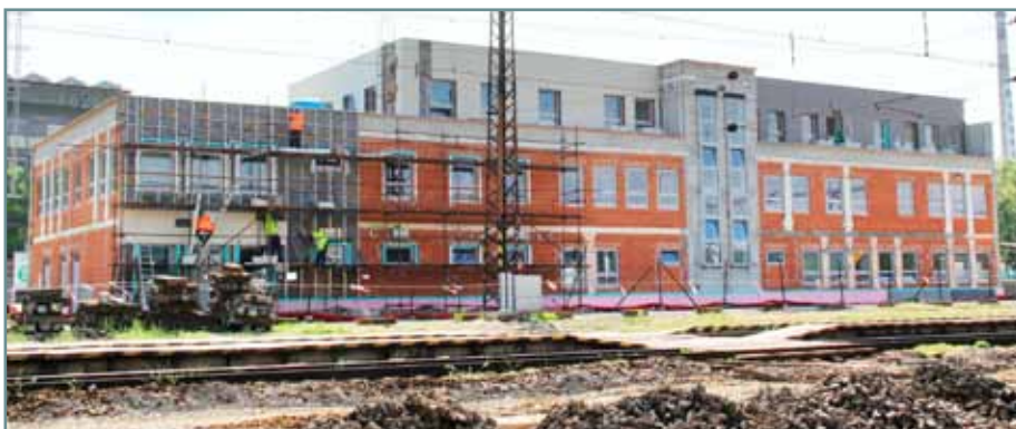
Pred dokončením je časť A novej výpravnej budovy, odovzdané už boli miestnosti na montáž technológie.
