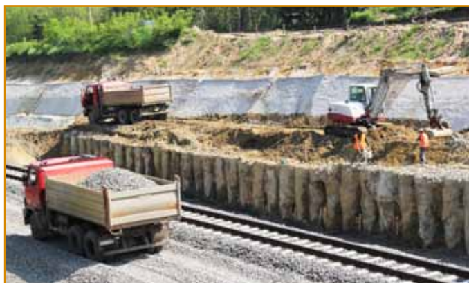
Hlinitopiesčítý geologický zlom, podmáčaný podzemnou vodou, pretála a stabilizovala pilótová stena.
