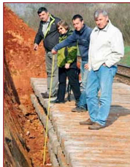
Výšku a uloženie podvalov hodnotia zľava Ing. Juraj Regec, vedúci prevádzky SMSÚ ŽTS TO Košice, Ing. Mária Senčáková zo sekcie ŽST OR Košice, vedúci prác Zdenko Klobušník z plešiveckého pracoviska SMSÚ ŽTS TO Košice a Ing. Andrej Marcinko, vedúci technického oddelenia sekcie ŽTS OR Košice.
