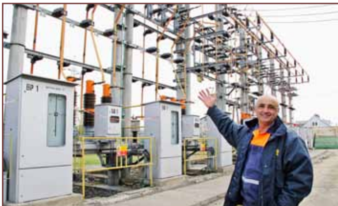
„Táto 22 kV rozvodňa už bude po rekonštrukcii umiestnená v budove,“ ukazuje Peter Pekarovič, prevádzkový elektromontér, obsluhujúci meniareň v Borši.
