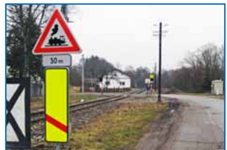
Nedostatočné rozhľadové pomery rozhodli o tom, že priecestie potrebuje priecestné zabezpečovacie zariadenie.
