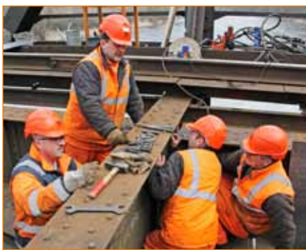
Zamestnanci MO Košice, zľava Jozef Bendík, Peter Bašista, Štefan Forgač a Ľubomír Lada pri montáži ocelových plechov, ktorými zosilnia skorodovanú stenu priečnika.
