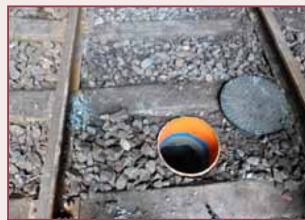
Šachta stredovej tunelovej stoky prešla prečistením.
