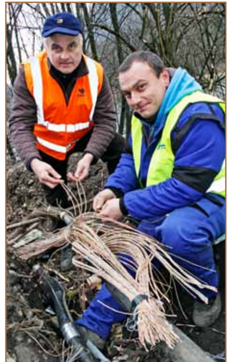
Káble, ktoré obmedzujú stavebnú činnosť, alebo priamo zasahujú do budovaných objektov, sa musia vopred preložiť mimo dosah stavby. Na mieste spájania pôvodného diaľkového kábla so 168 vodičmi a kábla uloženého v novej trase sme zastihli Ing. Štefana Barčíka, vedúceho SMSÚ OZT KT Žilina, ktorý asistuje Pavlovi Kubcovi z firmy ADTS, spol. s r. o..
