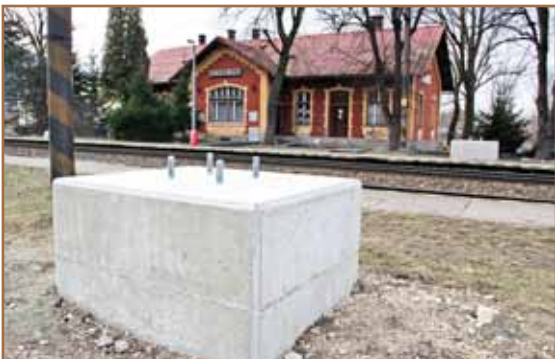
Nástupišťa na zástavke Strečno získajú pevný základ s demontovateľnou pochôdnou doskou, za ktorou bude plocha zo zámkovej dlažby. Vyrástli aj základy nových trakčných stožiarov ako náhrady za tie, ktoré svojou terajšou polohou nevyhovujú novému koľajovému riešeniu, nespĺňajú predpísanú vzdialenosť od koľaje alebo kolidujú so stavebnými objektmi.
