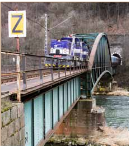
Pred samotnou rekonštrukciou trate sa ešte musí odstrániť havarijný stav mostného objektu na koľaji č. 2, na ktorom je prechodne obmedzená traťová rýchlosť na 20 km/h. Zosilnenie postihnutých oblastí stien priečnikov a výmenu skorodovaných styčkových plechov zrealizuje MO Košice.
