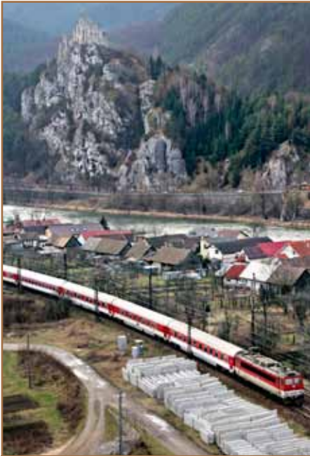
Pohľad na množstvo uložených betónových prefabrikátov napovedá, že trať pod Strečnom zažije rozsiahlu rekonštrukciu.
