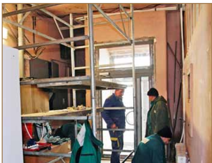
V týchto dňoch stavbári naplno pracujú vo vnútorných priestoroch.
