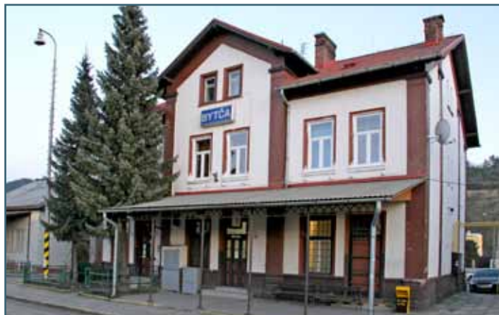
Začiatok modernizačných prác v ŽST Bytča je naplánovaný na 1. apríla 2014. Predpokladá sa, že stavebná činnosť v stanici skončí 30. septembra 2014.
