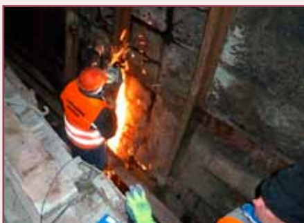
Príprava na rezanie zvislej drážky zvodnice.
