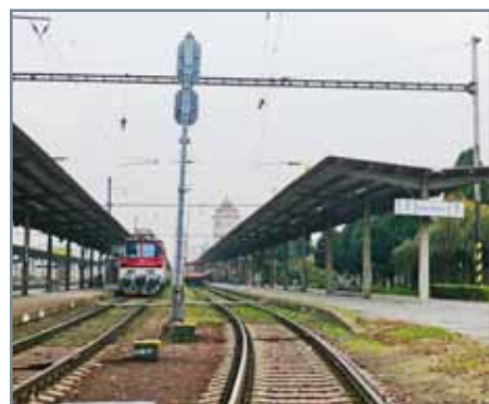
V Nových Zámkoch sa začne s rekonštrukciou nástupíšť, chodníkov, parkovacej plochy aj stavadla 2.
