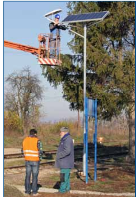
Zastávka Biňa je prvou v sieti ŽSR, ktorú osvetľuje energia získaná zo slnečných lúčov.
