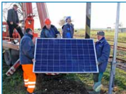
Fotovoltaický panel premieňa slnečnú energiu na elektrickú. Pri jeho umiestnení na stožiar asistovali aj elektromontéri z SMSÚ EE SZ Zvolen.
