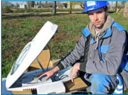
Nenápadný žltý štvorček v lampe, na ktorý ukazuje Jaroslav Prieložný z dodávateľskej firmy, sú vysokosvietivé LED-ky, ktoré postačia na osvetlenie zastávky.
