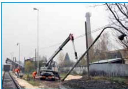
Za dva týždne boli stožiare postavené, pripojené, natreté bezpečnostnými pruhmi a očíslované.
