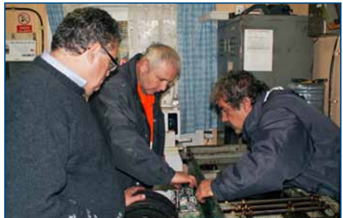
Ing. Miroslav Duda (vľavo) prednosta Sekcie OZT Leopoldov kontroluje Jána Podolca a Slavomíra Marka, návěstných majstrov SMSÚ OZT ZT Leopoldov pri úprave závislostí v stavadlovom prístroji na St. 3.
