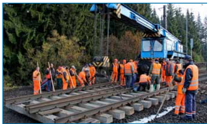
Tri zastarané výhybky, osadené pred rokom po vykoľajení vlaku, v októbri nahradili výhybky na betónových podvaloch.
