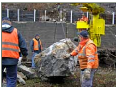
Vzduchovými zbjáčkami rozbili miestni železničiar obrovský balvan na dve polovice a následne ho odstránili z trate.
