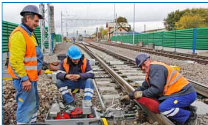
Po vypnutí výhybky z miestneho prestavovania bol následne na ňu namontovaný elektromotorický prestavník a zariadenie na kontrolu polohy jazykov.
