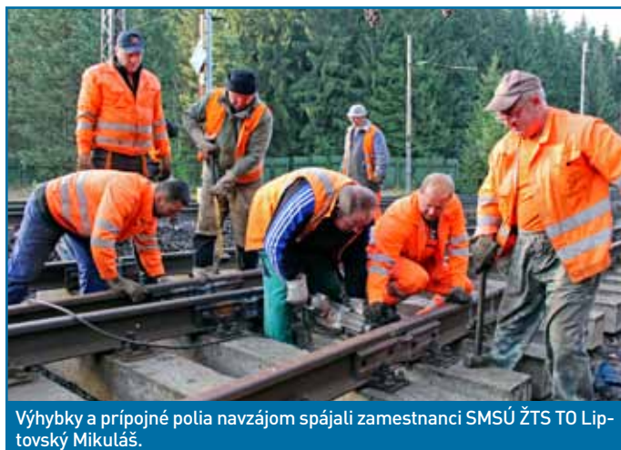
Tri zastarané výhybky, osadené pred rokom po vykoľajení vlaku, v októbri nahradili výhybky na betónových podvaloch.
