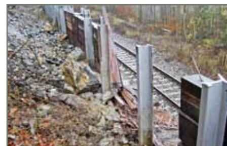
Skala prerazila zábrany a dopadla priamo na trať.
