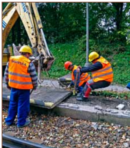
Na železničnej zastávke Brusno - Kúpele. Pôvodné nástupište nahradia prefabrikáty konštrukcie SUDOP.
