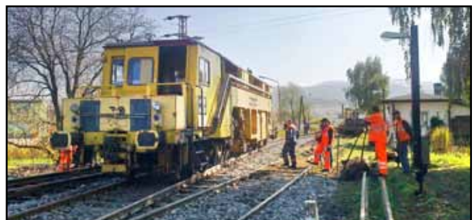
Zamestnanci SMSÚ ŽTS TO Topoľčany sa podieľali na výmene stupňových výhybiek za pomerové.
