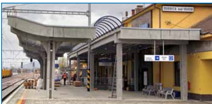
Časť pôvodnej piatej koľaje pred staničnou budovou zaniklo, na jej mieste stojí zväčšené prvé nástupište.
